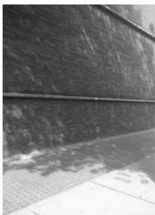
Fig. 9 Detalle de la entrada del muro sur de la Galería
