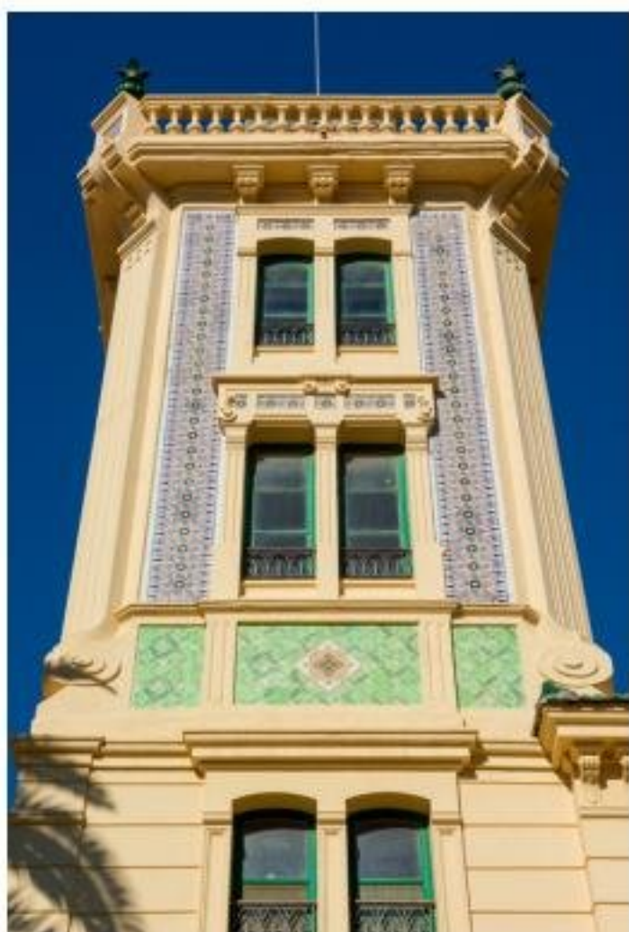
Imagen 6. Vista de la torre de la vivienda, con paños recubiertos de cerámica. Fotografía del autor.
