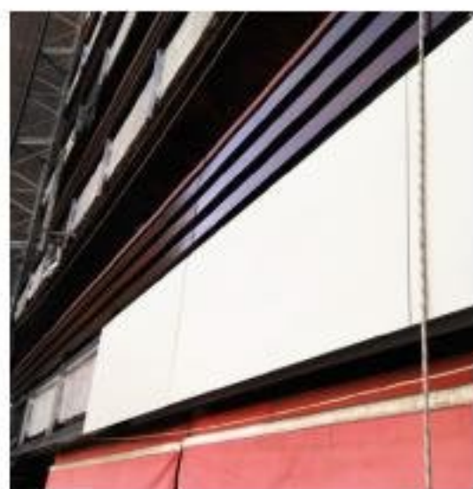
Imágenes 5 (izquierda) y 6 (derecha): Estructura de aluminio para sujeción de aplacado
