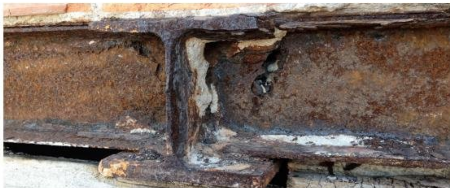
Imagen. 1: Detalle de perfil perimetral IPN-120
