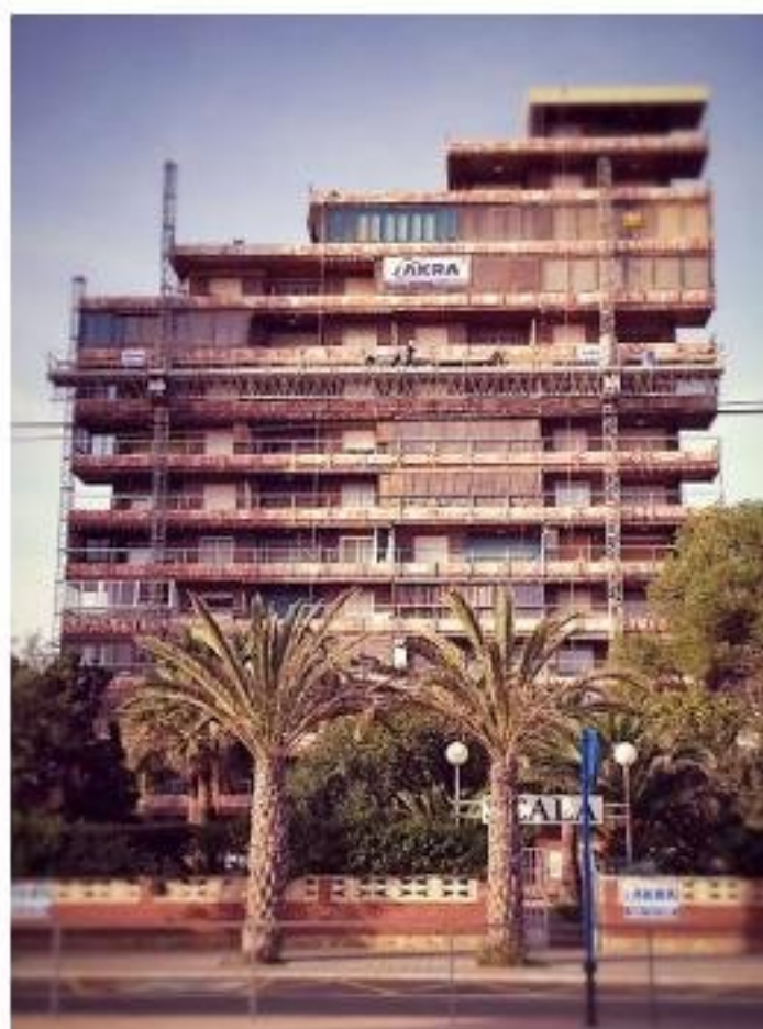
Imagen. 2: Vista del edificio en fase de saneado de antepechos
