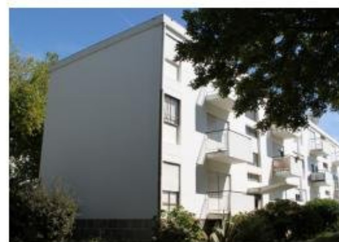
Imagen 4: Fernando Távora Unidad Residencial de Ramalde (1952-1960) Bloque de viviendas de la 1ª fase con cubiertas plantas
