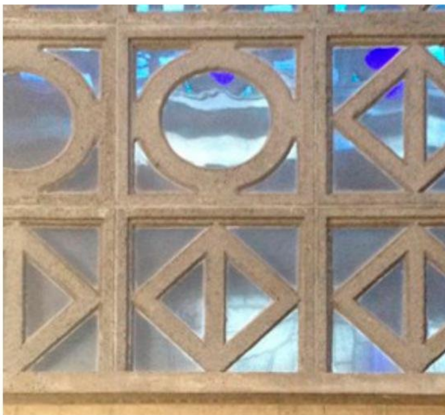
Imagen 1. Detalle de los claustra utilizados en la iglesia de Notre Dame du Raincy de Auguste Perret (1922)
