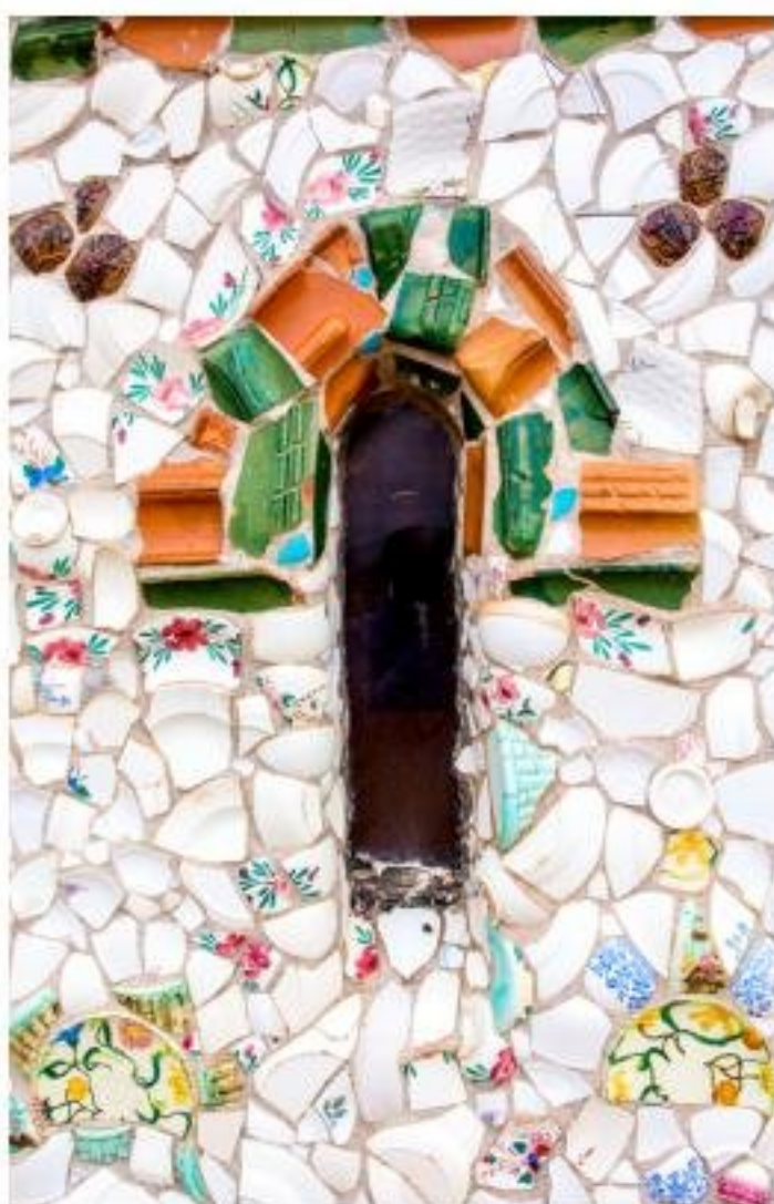
Imagen 7. Vista parcial del trencadís de cerámica y porcelana de la linterna de la torre de la vivienda. Fotografía del autor.
