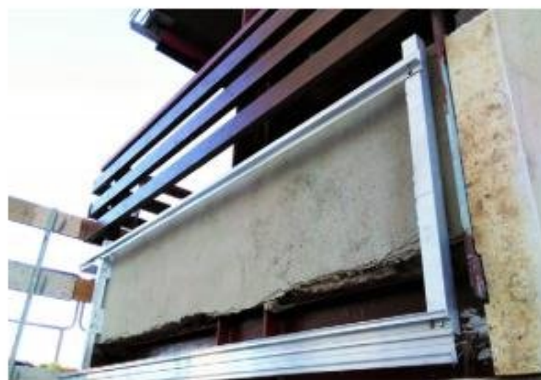
Imágenes 5 (izquierda) y 6 (derecha): Estructura de aluminio para sujeción de aplacado
