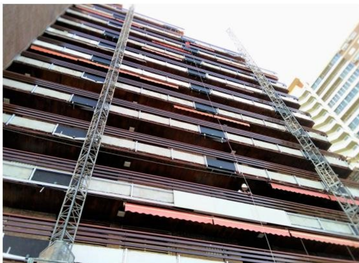
Imagen 9: Sistema de desagüe interior en fachada posterior
