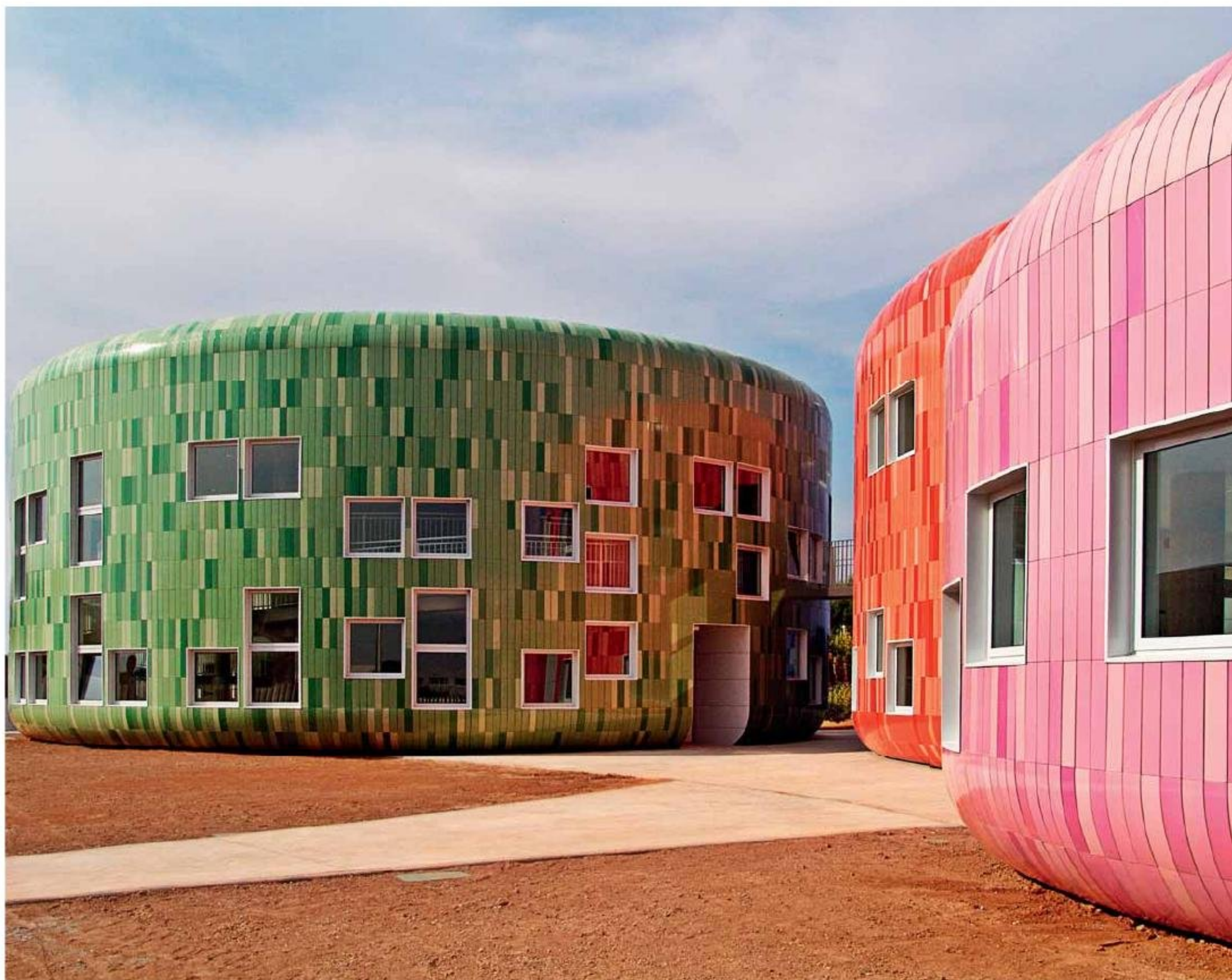
Centro di Educación Infantil e Centro di Innovación para la Infancia. Four Square Arquitectos. Facciata in ceramica di Natucer.
