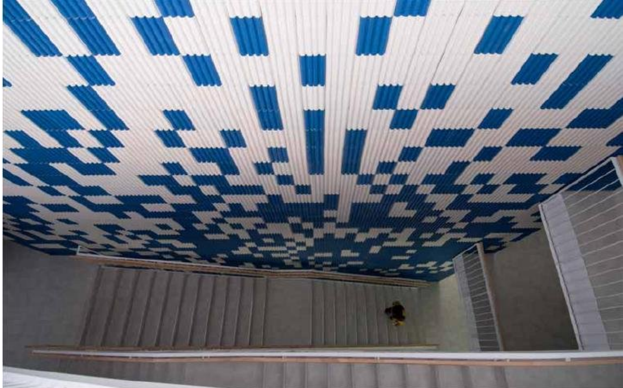
C.E.P.A. Los Llanos à Albacete, du studio Matos-Castillo Arquitectos. Lambris extérieur et vestibule avec revêtement céramique ondulé en grès émaillé bleu et blanc.
