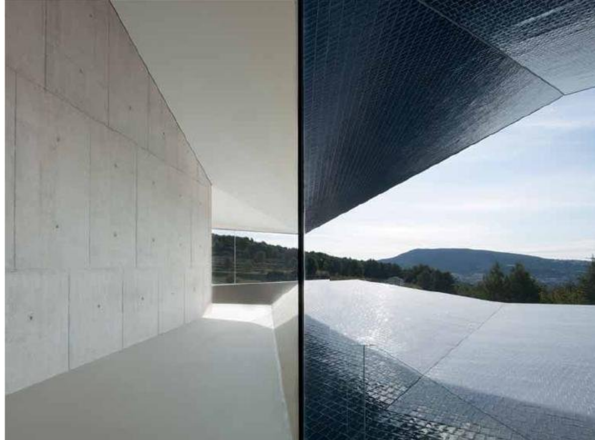
Auditorium de Teulada-Moraira. Architecte Francisco Mangado. Revêtement céramique. Photo de Juan Rodríguez.
