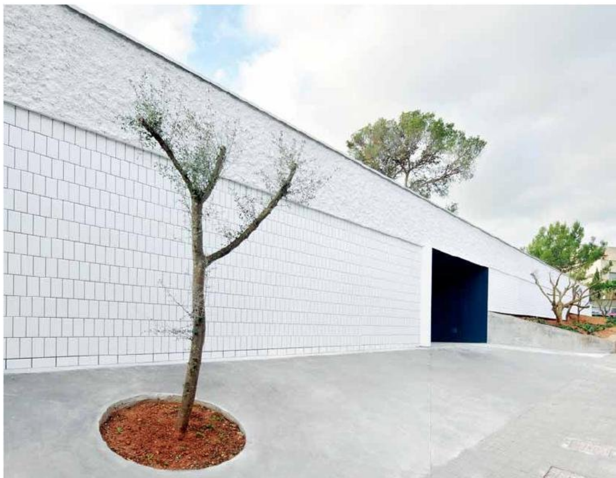
Centro de Día y Actividades Comunitarias di Flexo Arquitectura. Rivestimento di facciata e interno con Cerámica Alcora bianco 10x20 cm.
