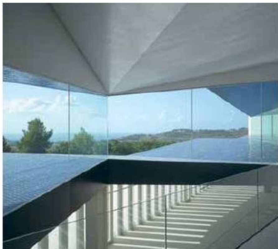
Auditorio di Teulada-Moraira. Architetto Francisco Mangado. Rivestimento ceramico. Fotografia de Roland Halbe.
