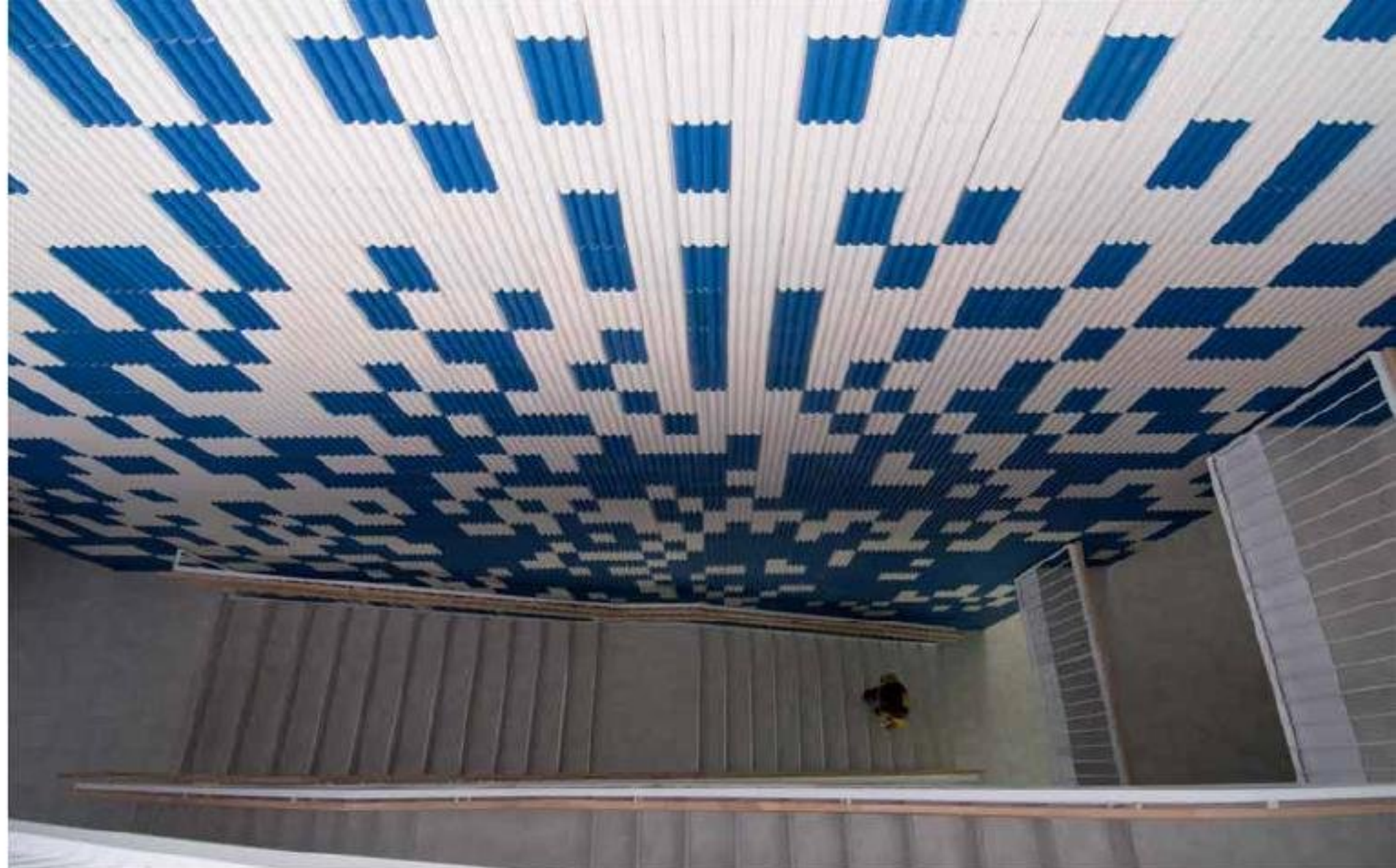
C.E.P.A. Los Llanos ad Albacete di Matos-Castillo Arquitectos. Zoccolo esterno e atrio con rivestimento ondulato ceramico di gres smaltato azzurro carico e bianco.
