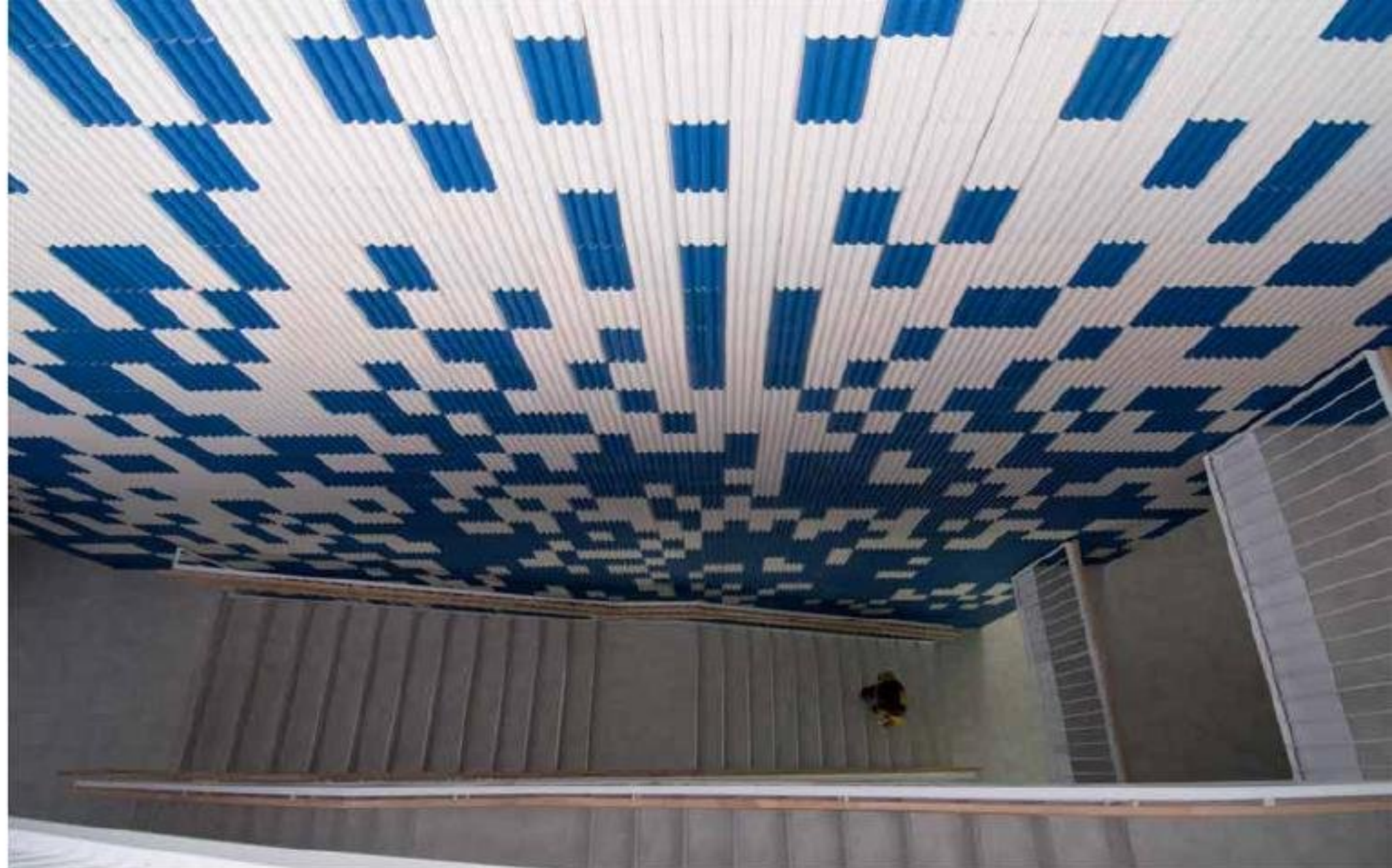
C.E.P.A. Los Llanos en Albacete de Matos-Castillo Arquitectos. Zócalo exterior y vestíbulo con revestimiento ondulado cerámico de gres esmaltado azul y blanco.
