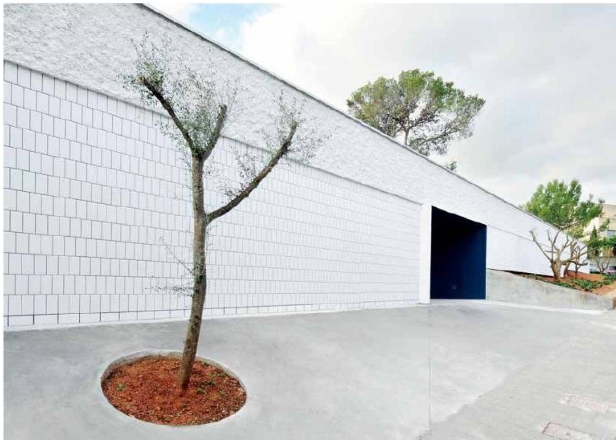
Centro de Día y Actividades Comunitarias de Flexo Arquitectura. Revestimiento fachada e interior de Cerámica Alcora blanco 10x20 cm.
