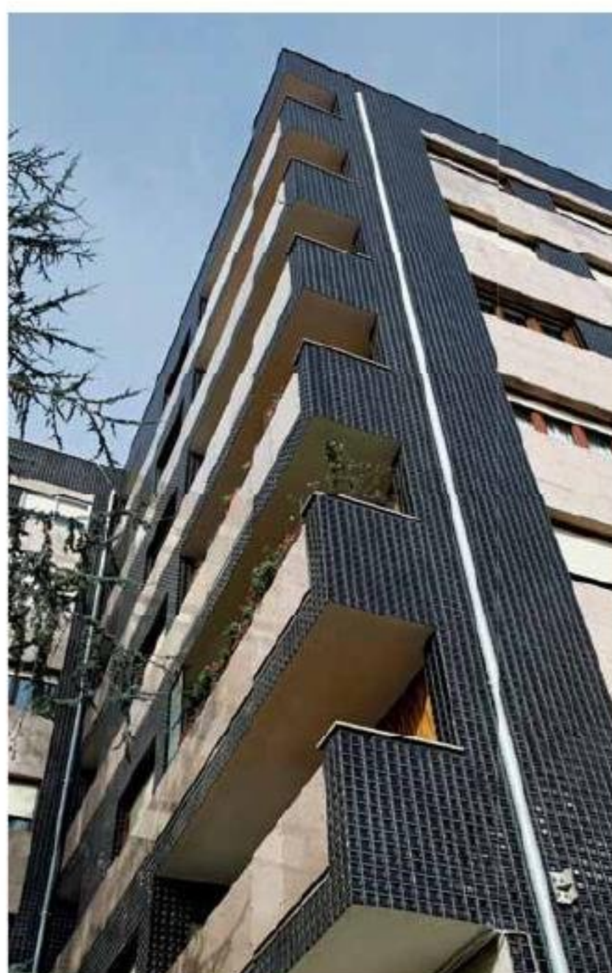
Rénovation d'un bloc de logements à Leioa (province de Biscaye, Espagne) dont les propriétaires souhaitent maintenir l'utilisation de céramique sur la façade, mais avec un design plus moderne et à la fois atemporel. Les pièces sont en grès de 10x10 cm et valables pour l'extérieur (Dune Cerámica, série Black Infinity - Collection Emphasis Ceramics).
