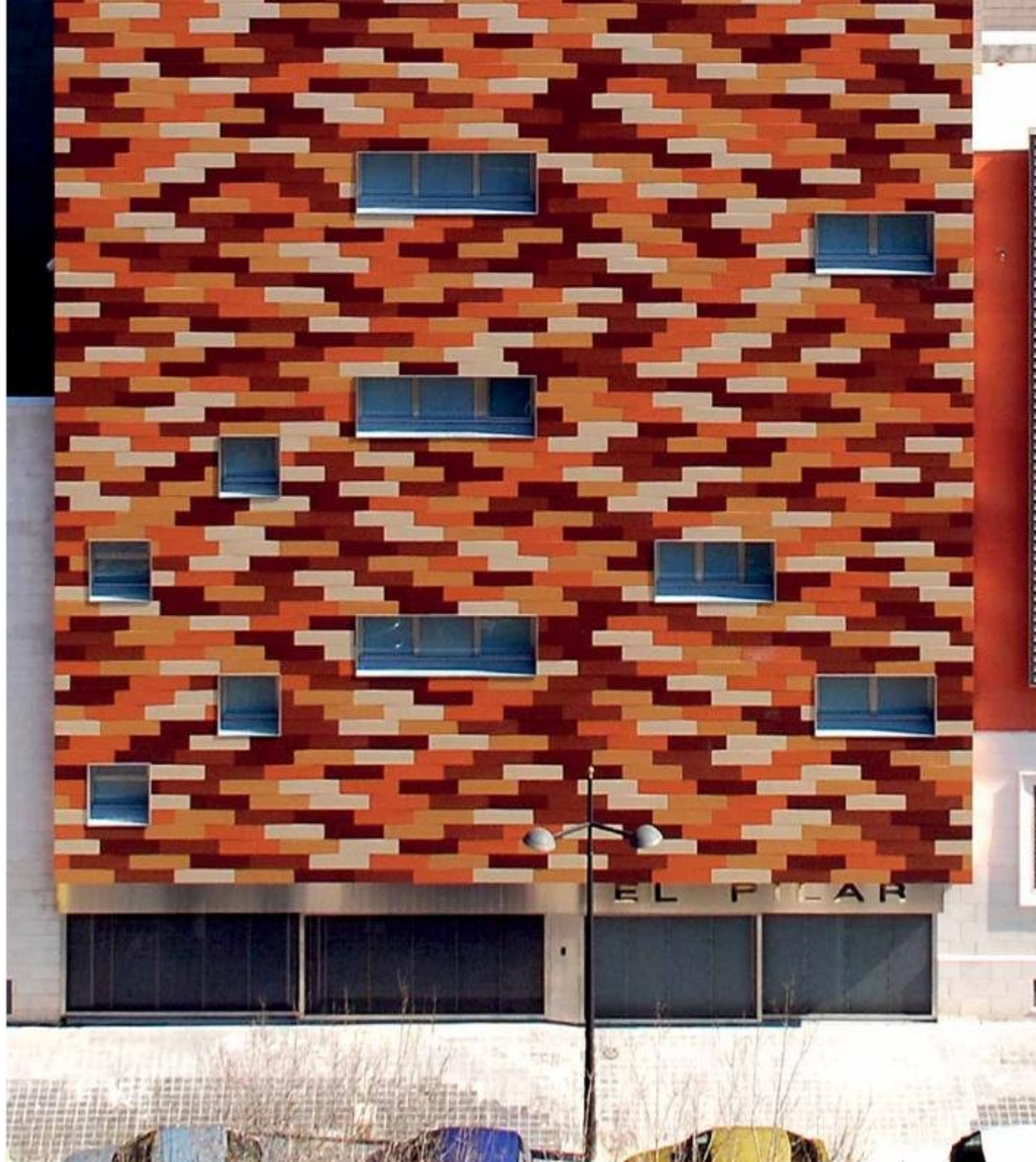
Le collège El Pilar de Valence a été transformé pour rénover les installations et gagner en confort tout en améliorant la climatisation du bâtiment.
