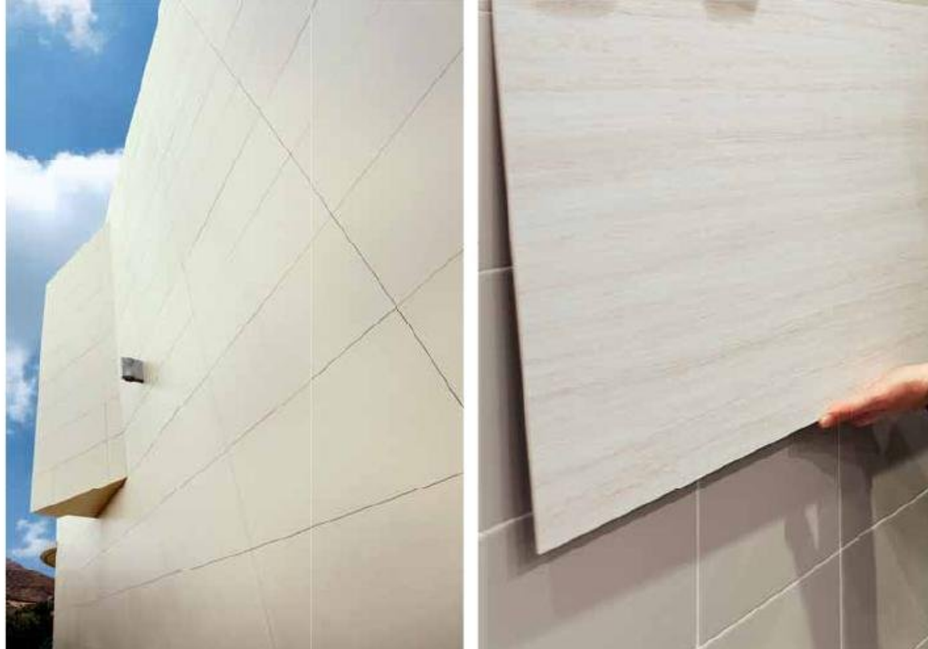
Rénovation d'un logement unifamilial, Murcie (Espagne). La céramique de fine épaisseur permet de rénover les espaces extérieurs et intérieurs sans devoir éliminer les revêtements existants, ce qui évite les travaux de démolition, les bruits et la production de déchets. Série Coverlam, grès porcelainé de 3,5 mm d'épaisseur.
