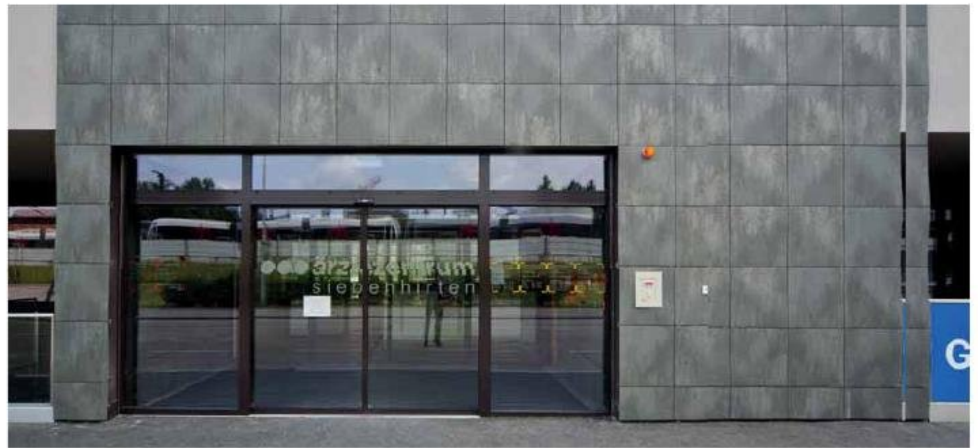
Façade ventilée d'Apavisa Porcelánico d'aspect métallisé, de la collection Arch Concept dans le centre de Vienne.
