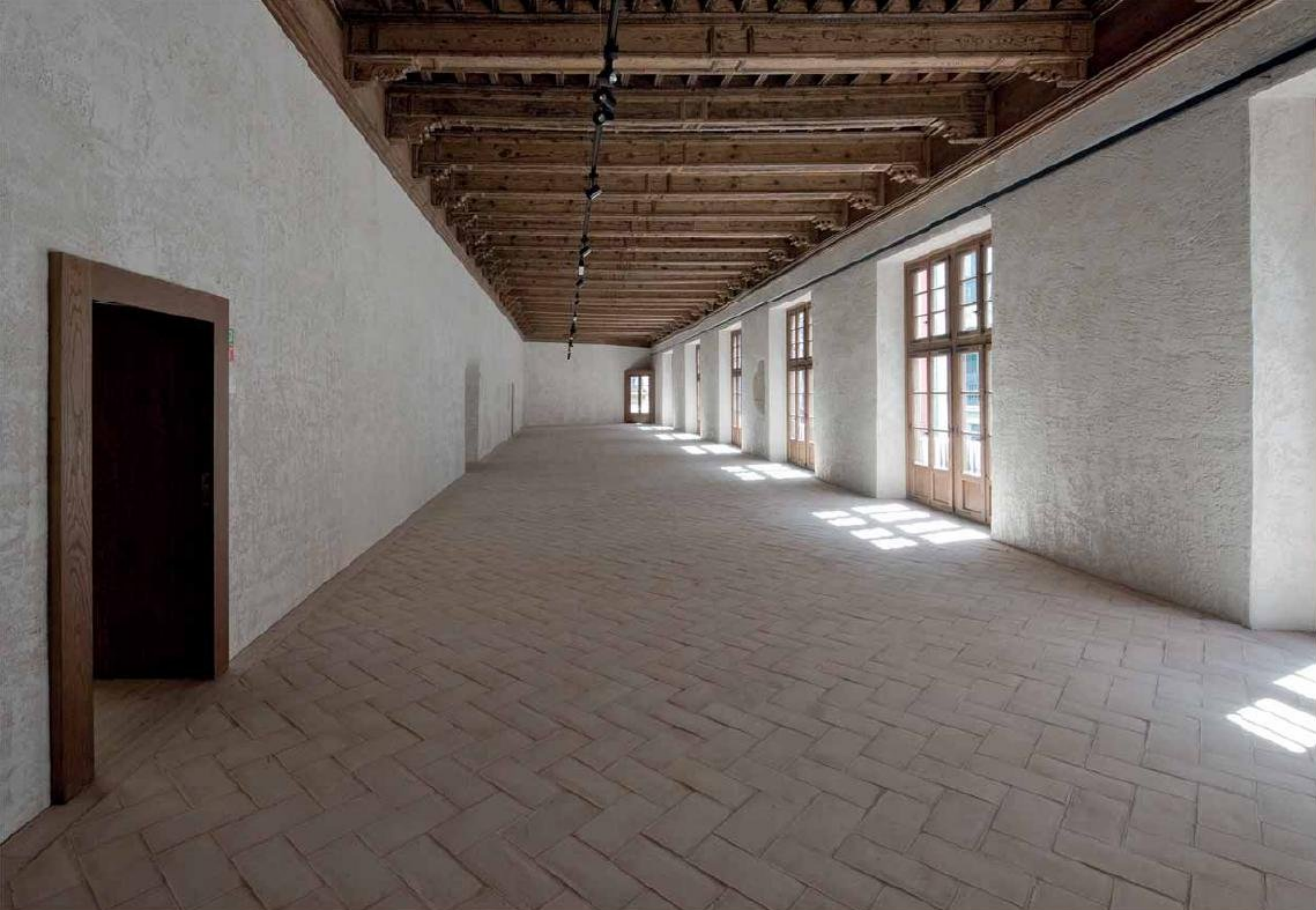
Nella riqualificazione della Casa del Condestable (Pamplona) di Tabuenca & Leache, gli elementi in terracotta utilizzati e fabbricati appositamente sono il tratto di unione tra il passato e il presente.
