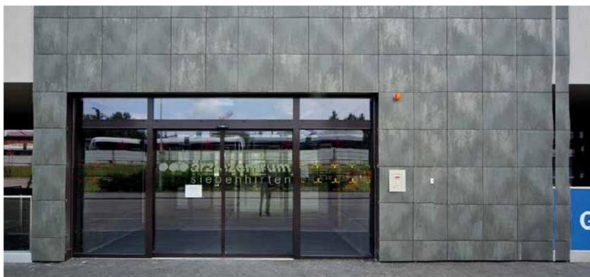
Facciata ventilata di Apavisa Porcelánico con aspetto metallizzato della collezione Arch Concept nel centro di Vienna.
