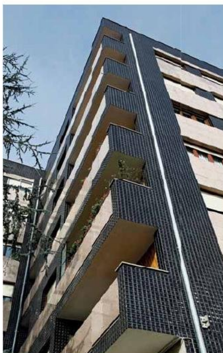
Riqualificazione di un edificio residenziale a Leioa (Vizcaya) nel quale i proprietari hanno voluto mantenere la ceramica in facciata, ma con una forma più moderna e nello stesso tempo in uno stile intramontabile. Gli elementi sono in gres nel formato 10x10 adatti all'impiego in esterni (Dune Cerámica, serie Black Infinity - Collezione Emphasis Ceramics).
