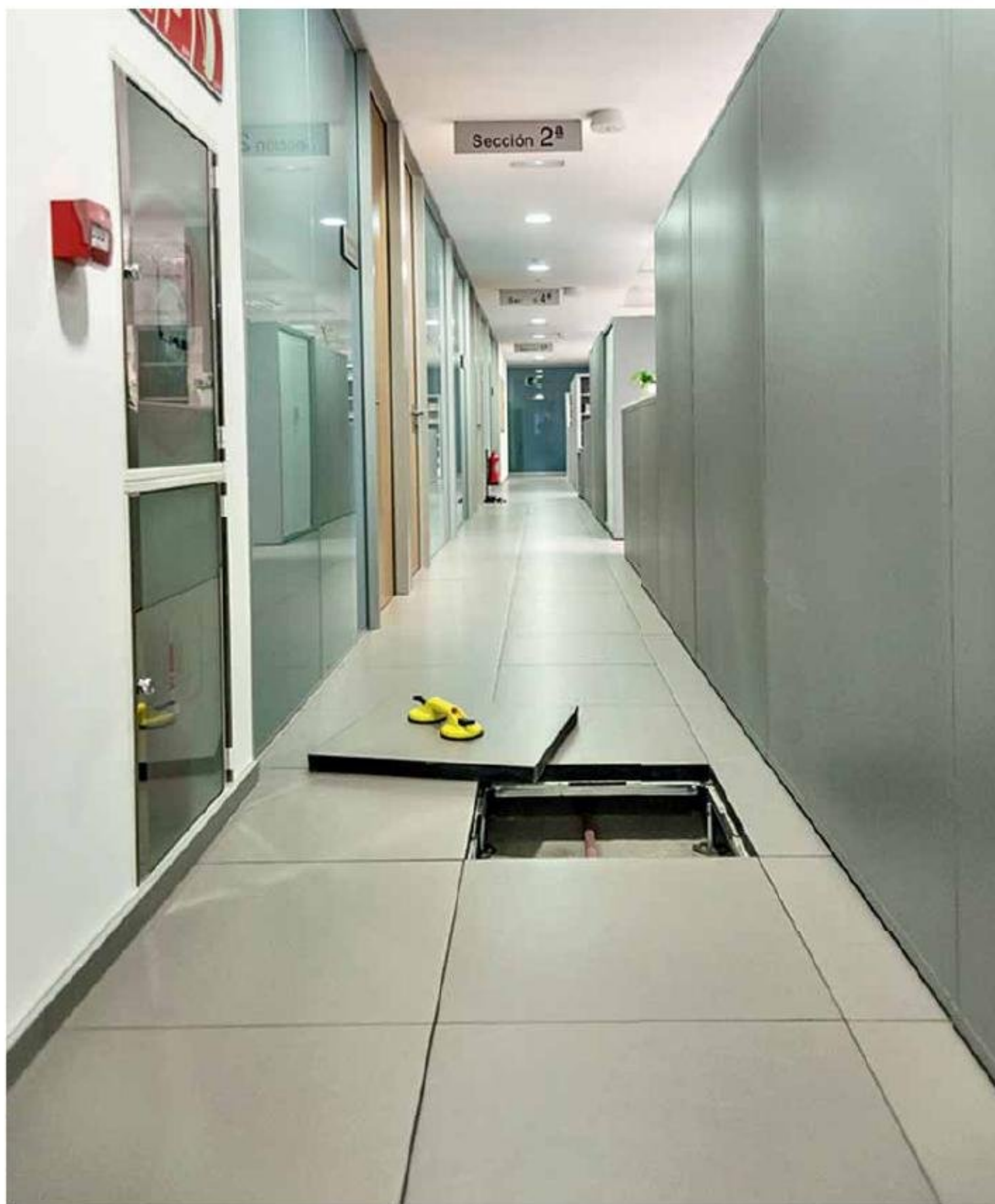
Suelo sobreelevado en las instalaciones de la Audiencia Provincial de Zaragoza. Gres porcelánico de Pamesa Cerámica, serie Cosmos.
