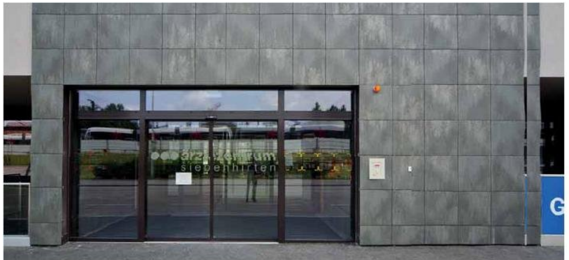
Fachada ventilada de Apavisa Porcelánico con aspecto metalizado de la colección Arch Concept en el centro de Viena.
