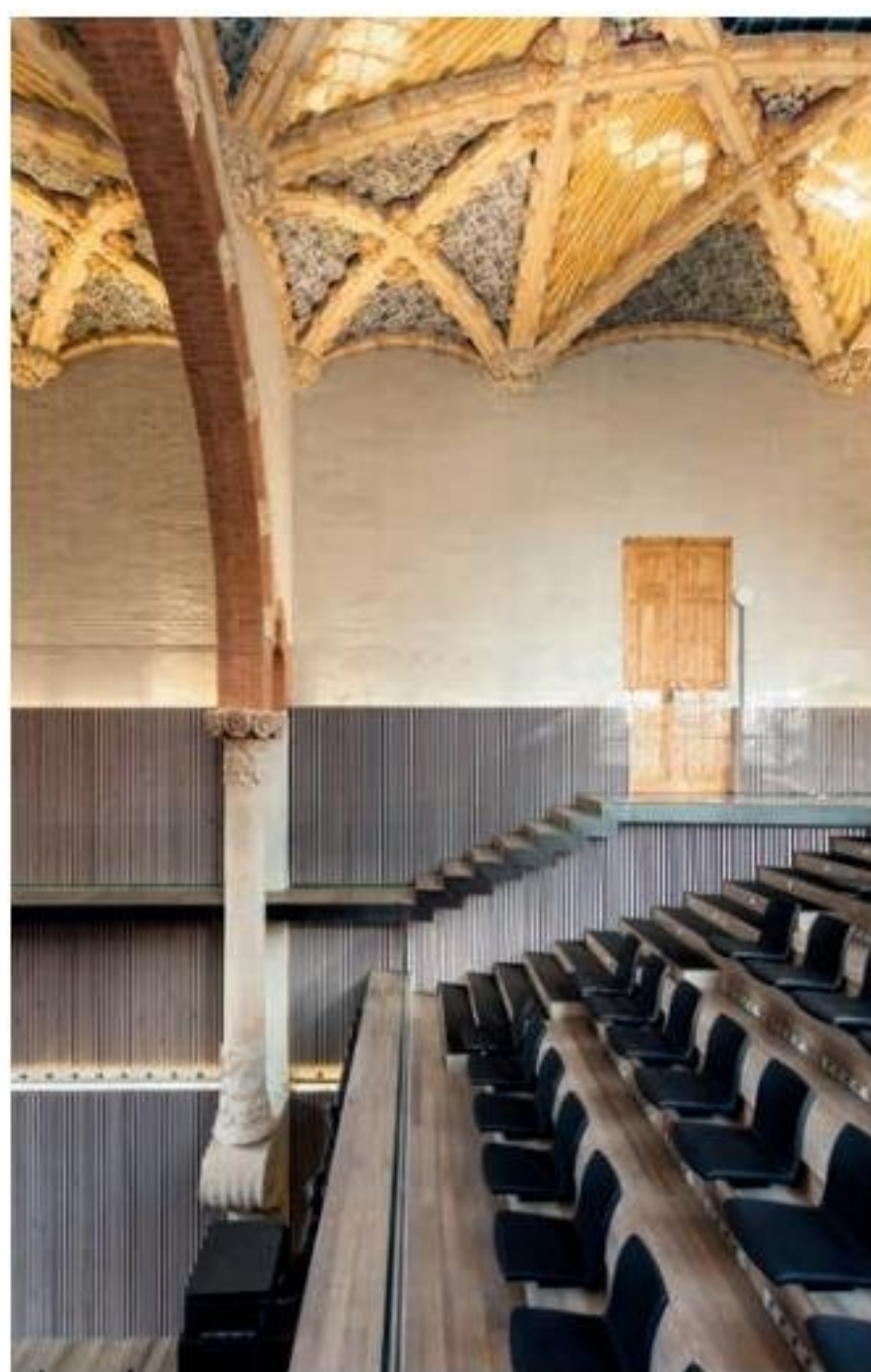
Restauration du Pavillon de l'Administration de l'enceinte moderniste de Sant Pau, de Joan Nogué. Photos : Marcela Grassi et Robert Ramos.
