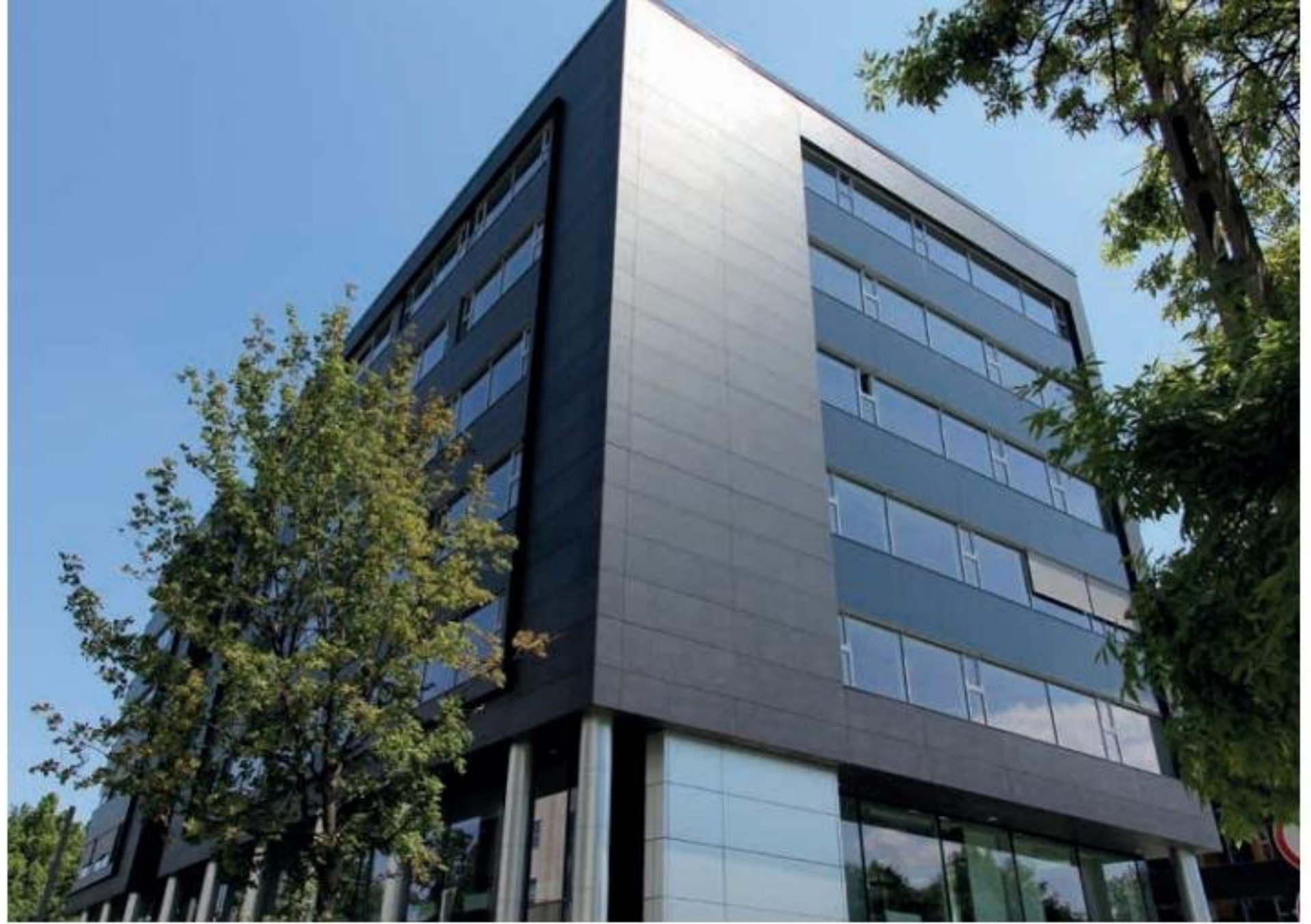
L'usage au niveau des façades de pièces céramiques apporte d'autres avantages tels que la résistance au feu, aux changements brusques de température et à l'usure par l'action du rayonnement UV.
