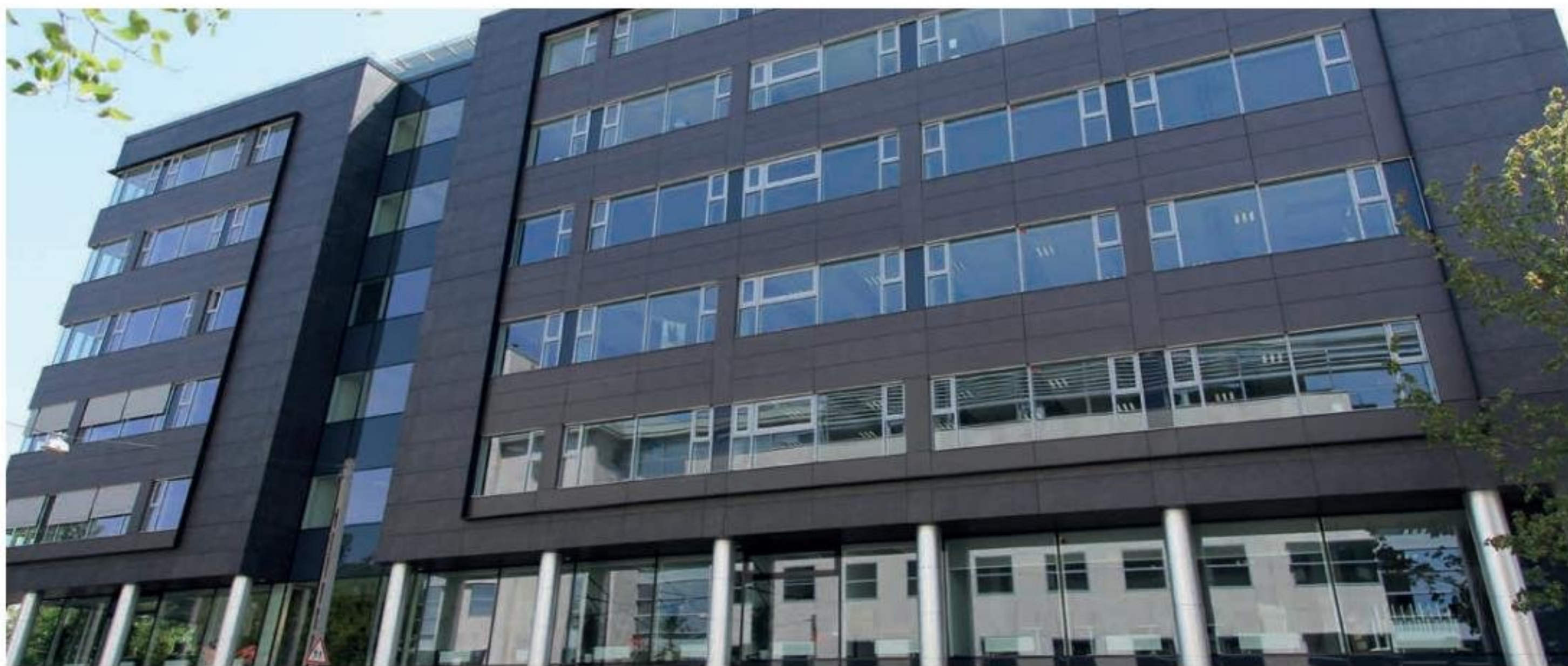
L'edificio "Green House" di Budapest si distingue per l'ampio uso di lamine ceramiche in facciata. Techlam Levantina, serie Vulcano.
