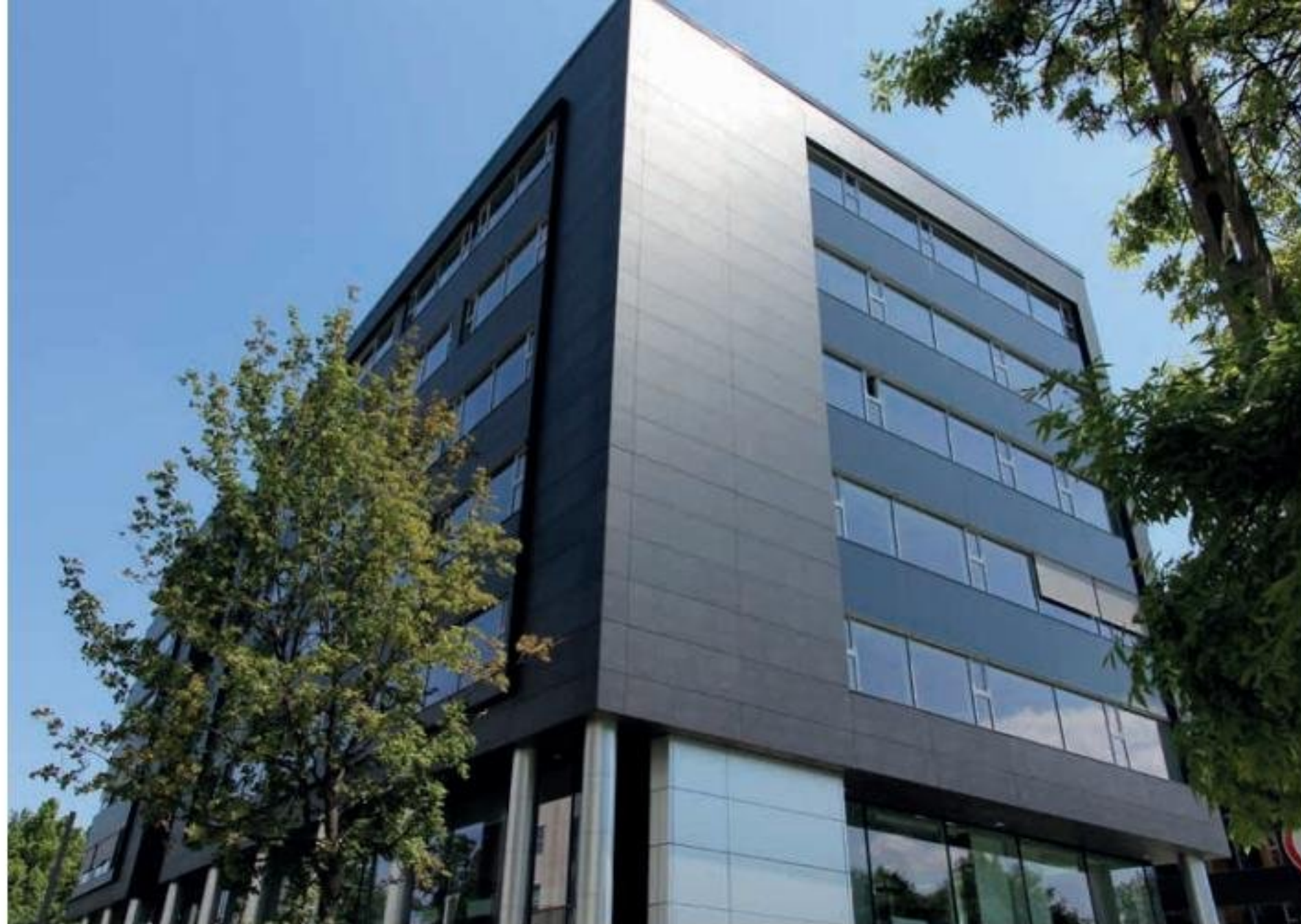
L'impiego in facciata di elementi ceramici offre altri vantaggi come la resistenza al fuoco, ai cambi bruschi di temperatura e al degrado dovuto alla azione dei raggi UV.
