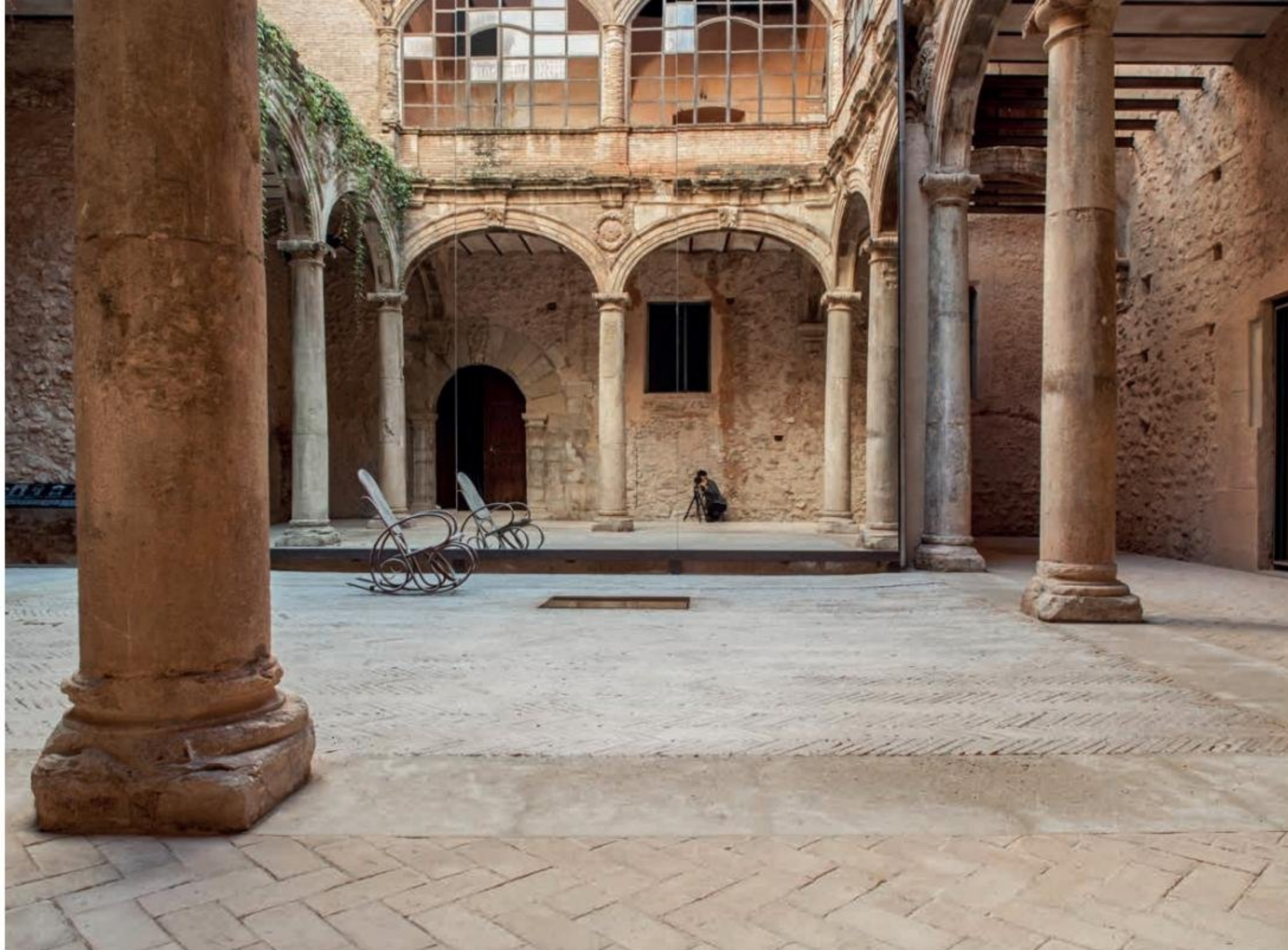
Recupero del chiostro del Palau-Castell di Betxí, di Fabricante de Esferas. Fotografia: Milena Villalba.
