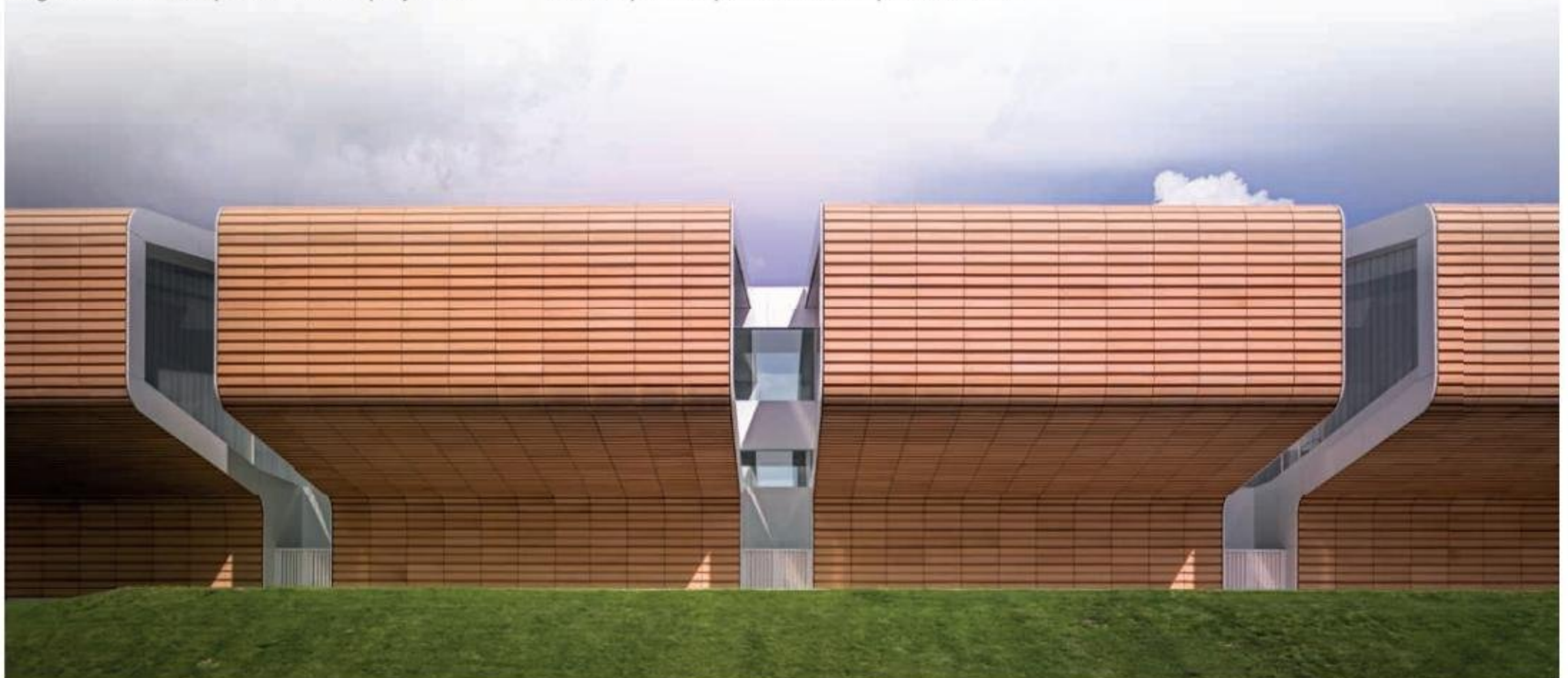
Façade ventilée céramique de l'immeuble de logements de Jose Ignacio Linazasoro à Baracaldo.
