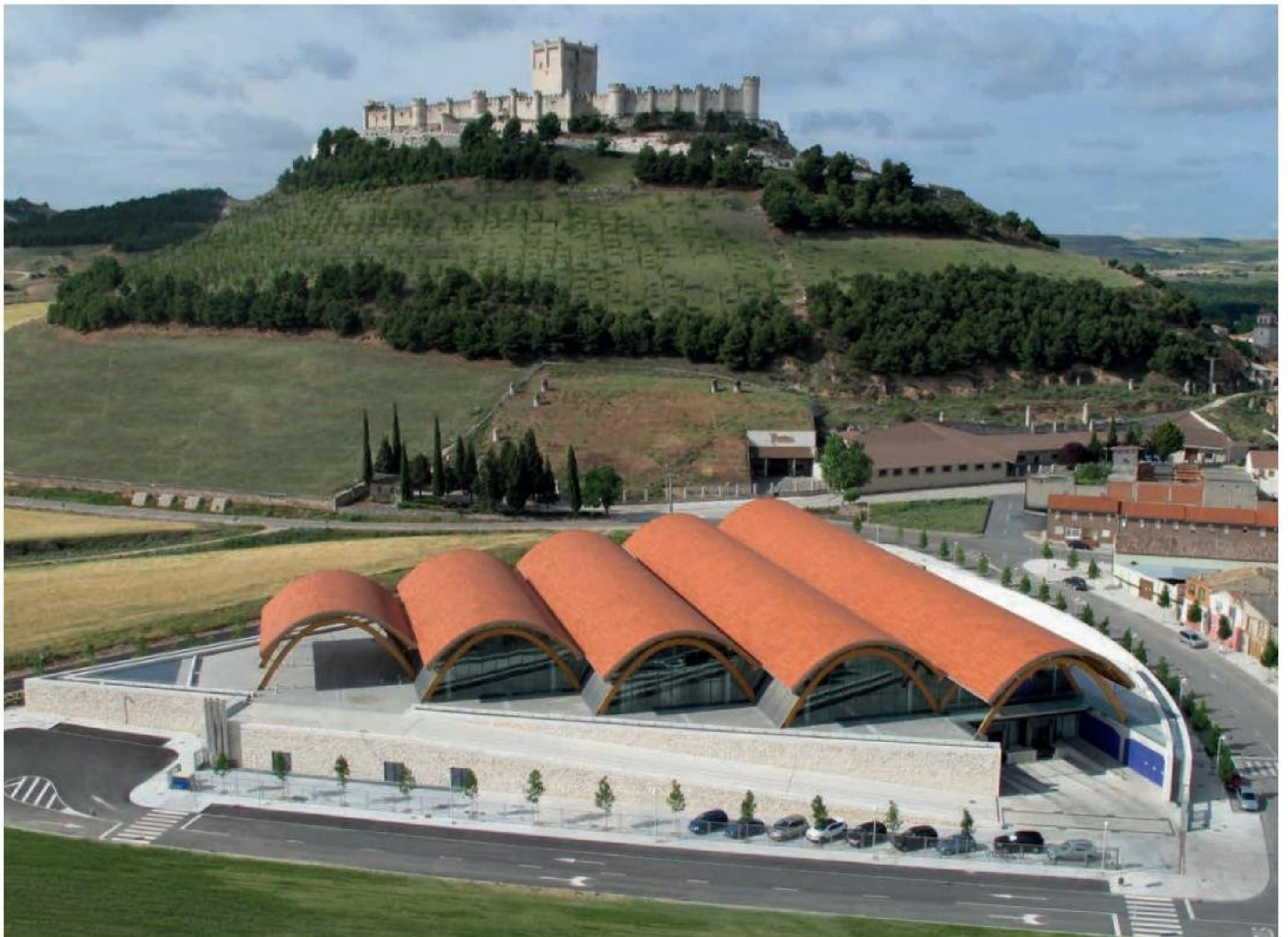
Toiture céramique des Caves Protos à Peñafiel, de architectes Rogers Stirk + Alonso Balaguer asociados.
