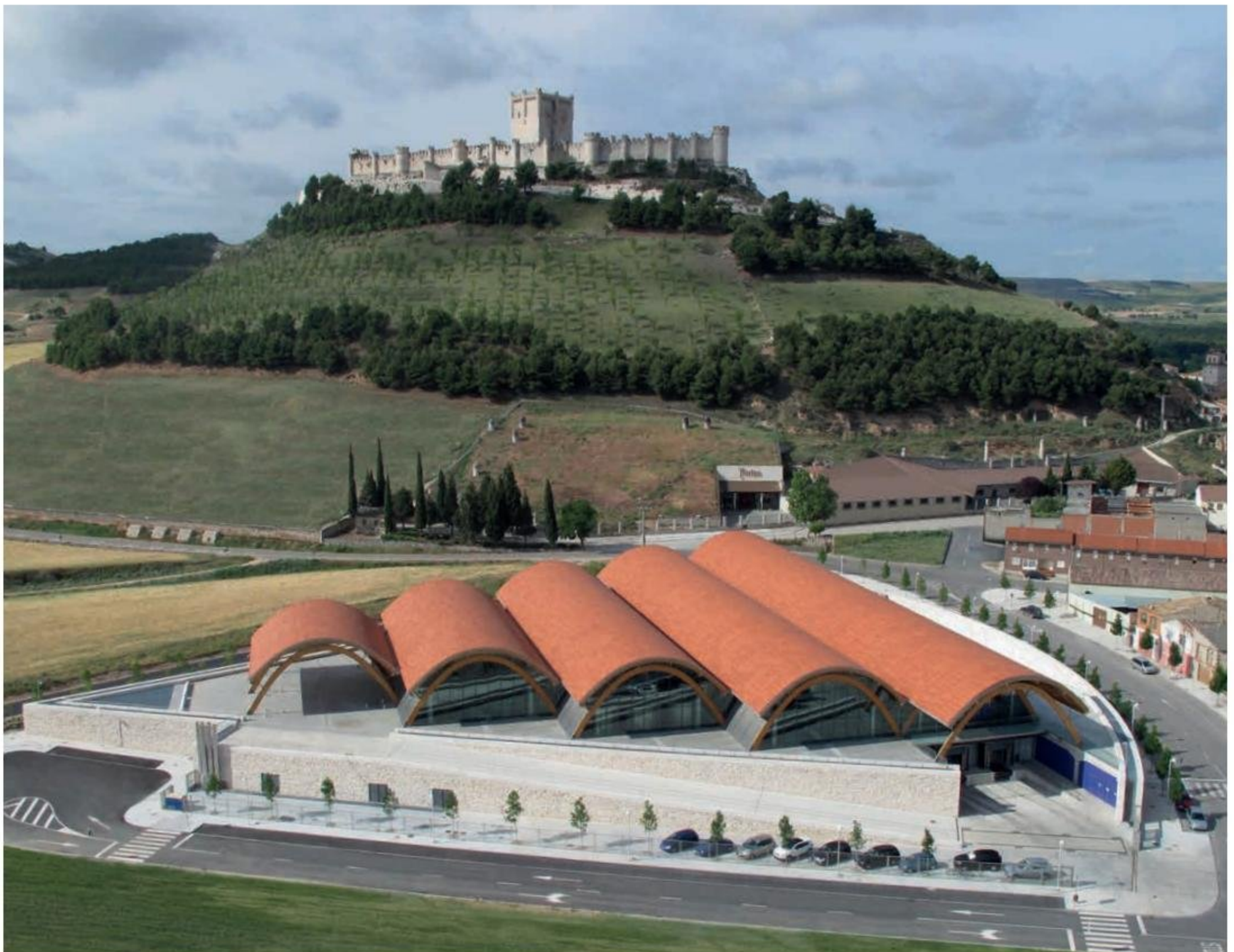
Cubierta cerámica de las Bodegas Protos en Peñafiel, de de los arquitectos Rogers Stirk + Alonso Balaguer asociados.
