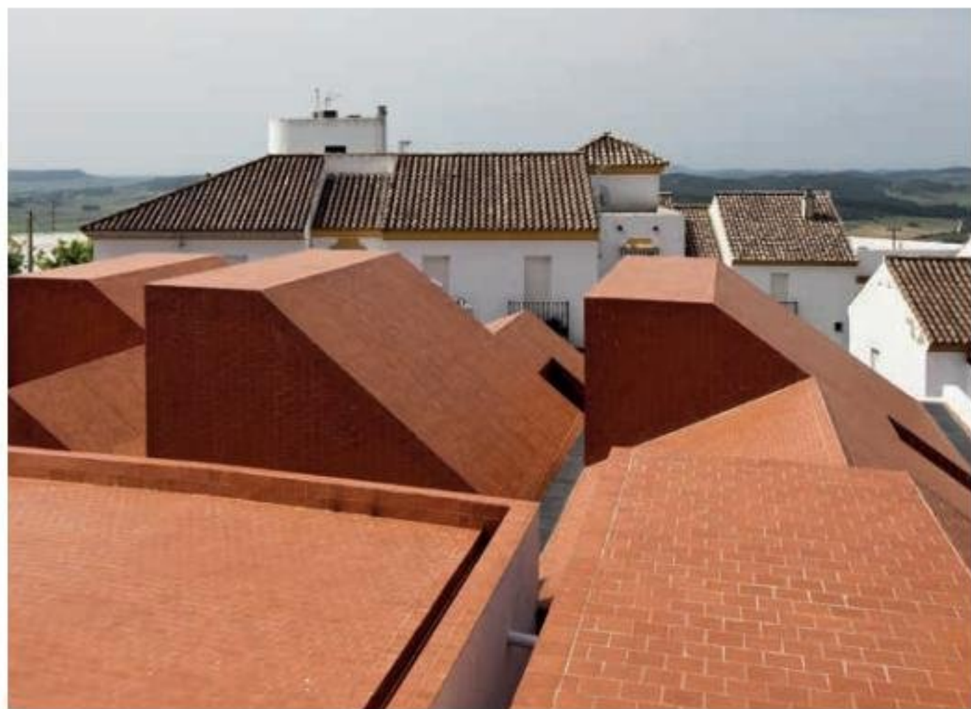
Scuola Alberghiera al Matadero di Sol 89. Fotografia: Fernando Alda.
