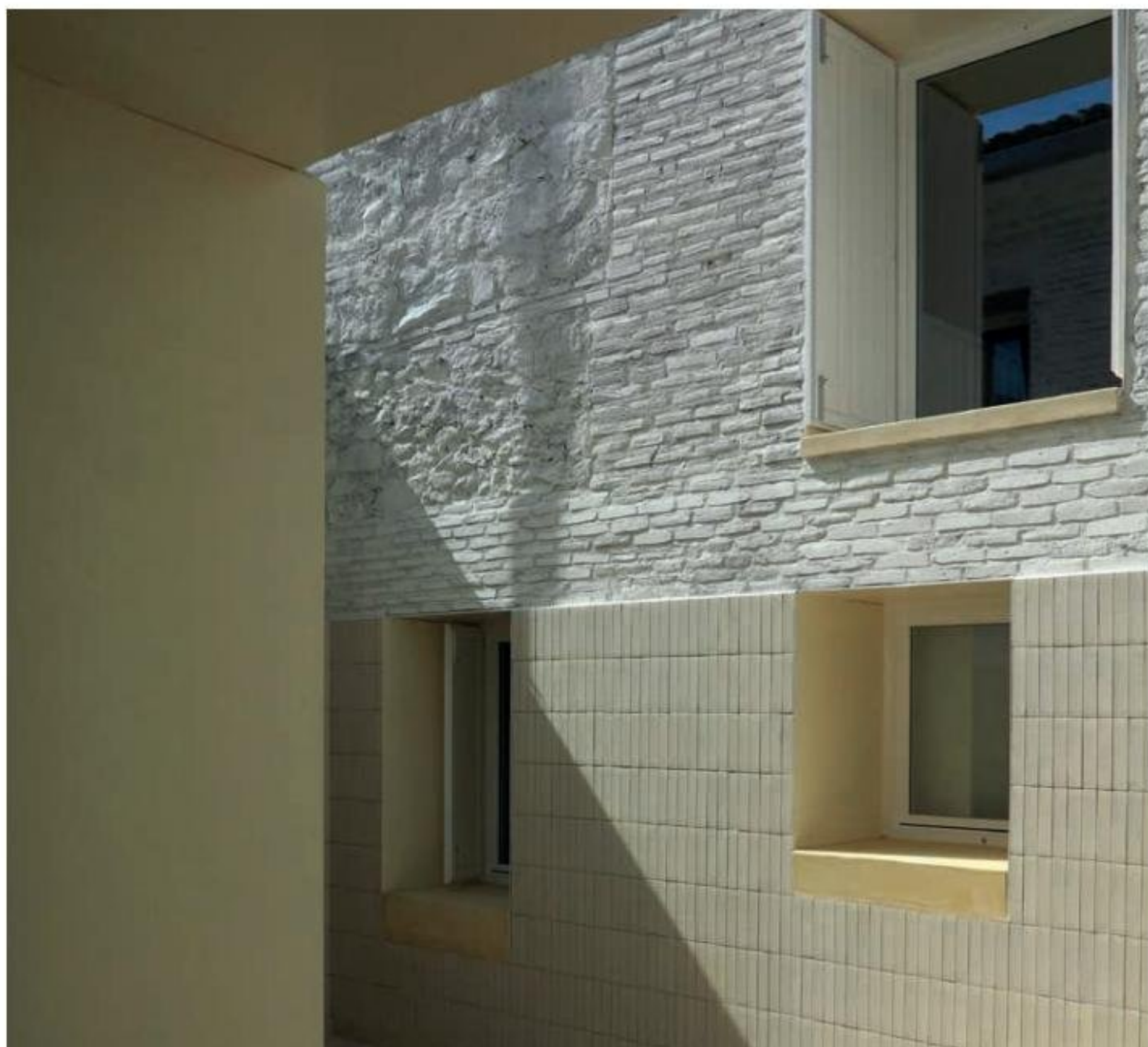
“Dos Viviendas en Oropesa” de Paredes Pedrosa Arquitectos. Foto: Luis Asín.
