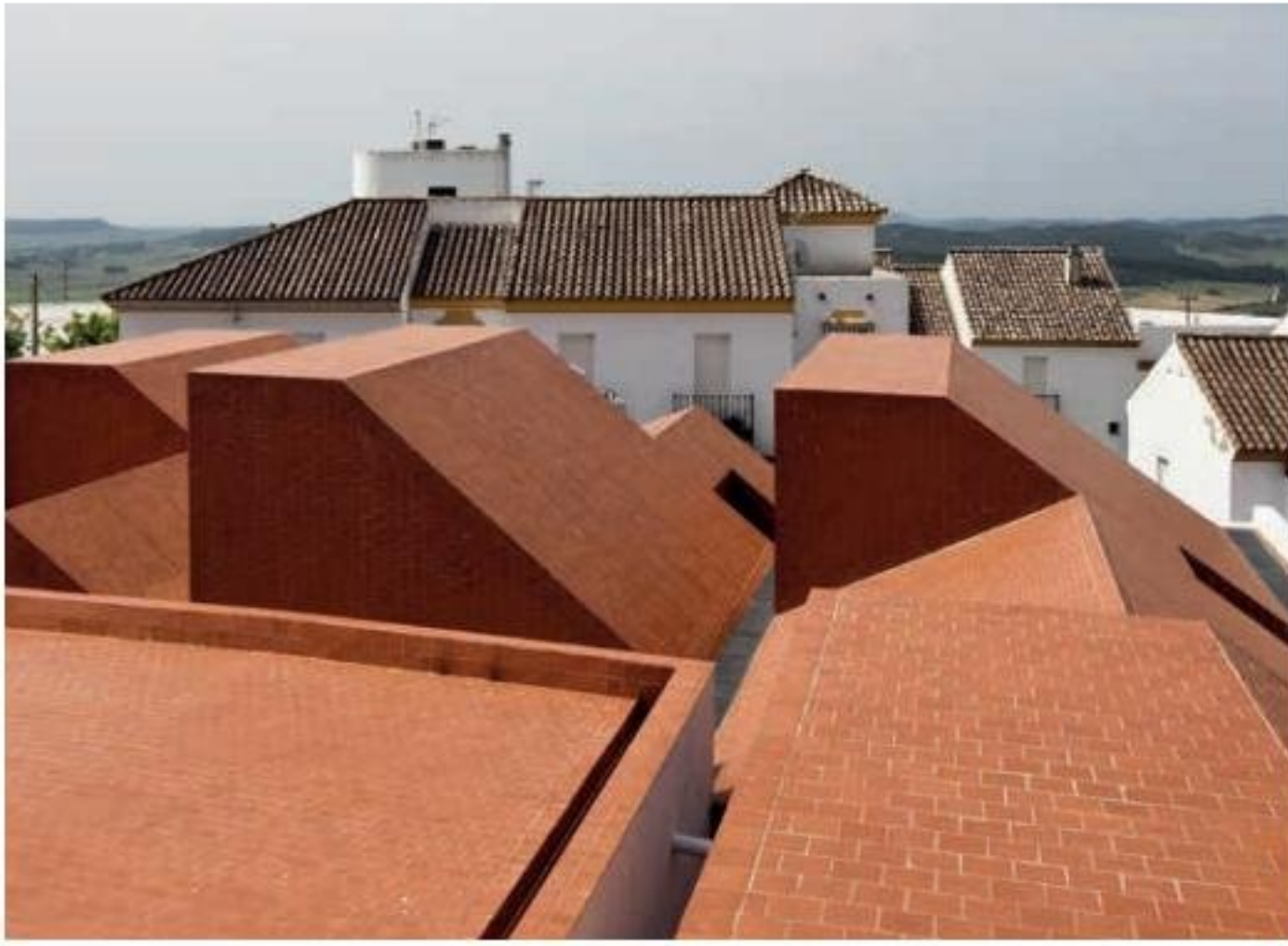
Escuela de Hostelería en Matadero de Sol 89. Fotografía: Fernando Alda.
