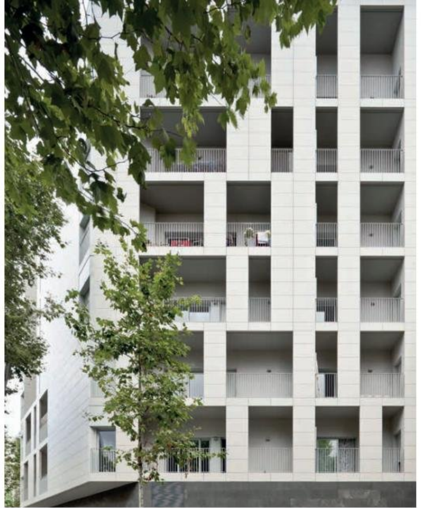
Facciata ceramica ventilata in abitazioni plurifamiliari a Barcelona. Prodotto dell'azienda Roca serie Pure.
