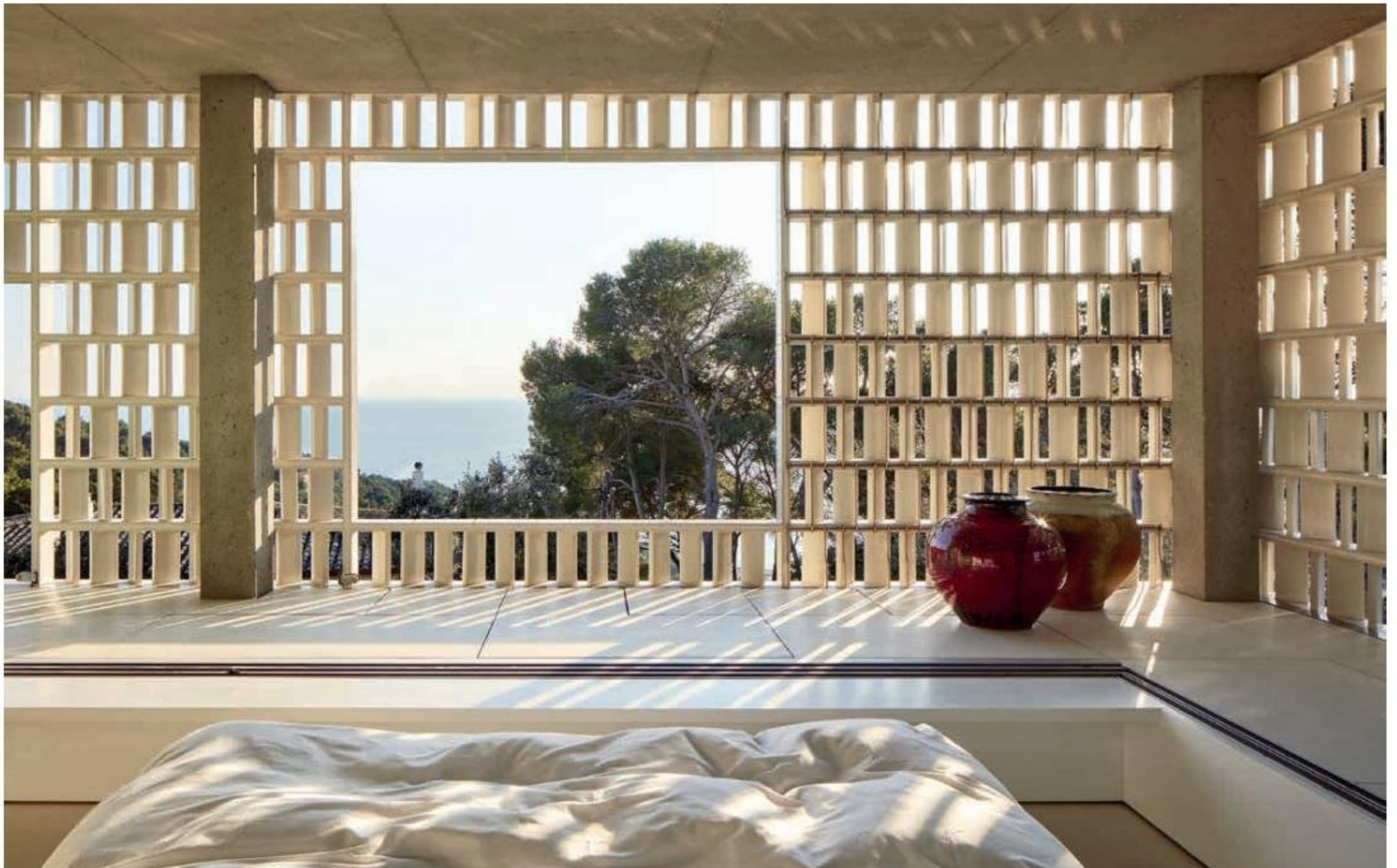
Control de soleamiento con despiece cerámico. Casa Celosía de Emiliano López Matas.
