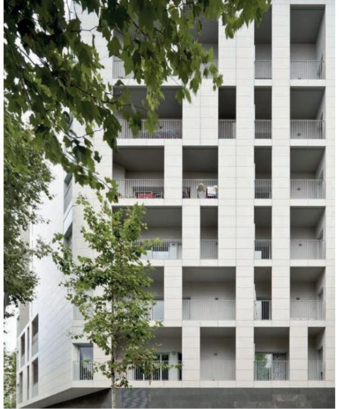
Fachada ventilada cerámica en vivienda plurifamiliar en Barcelona. Producto de la firma Roca serie Pure.
