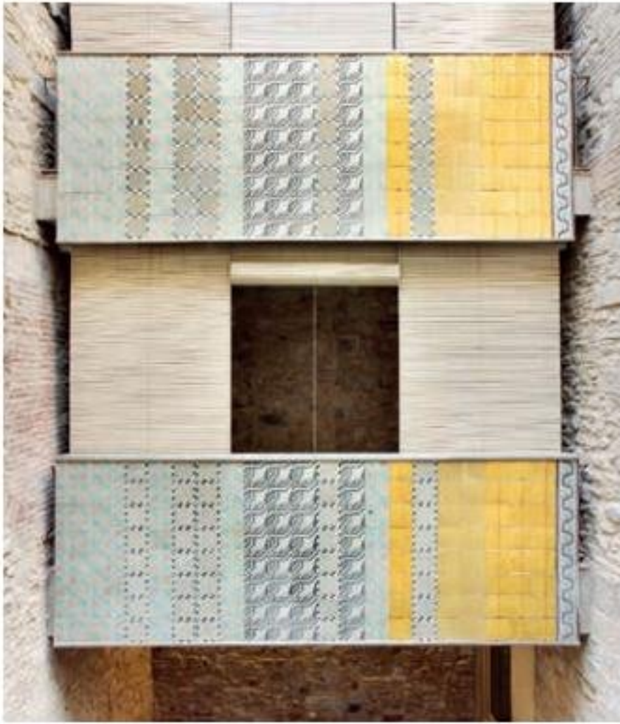
'Maison Collage' de Bosch Capdeferro Arquitectos. Photographie de José Hevia.
