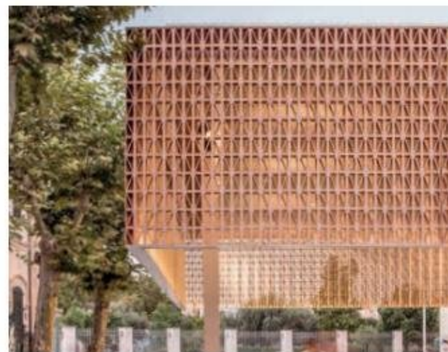
Nuovo ingresso alla stazione intermodale di Palma. Fotografia: Adrià Goula.
