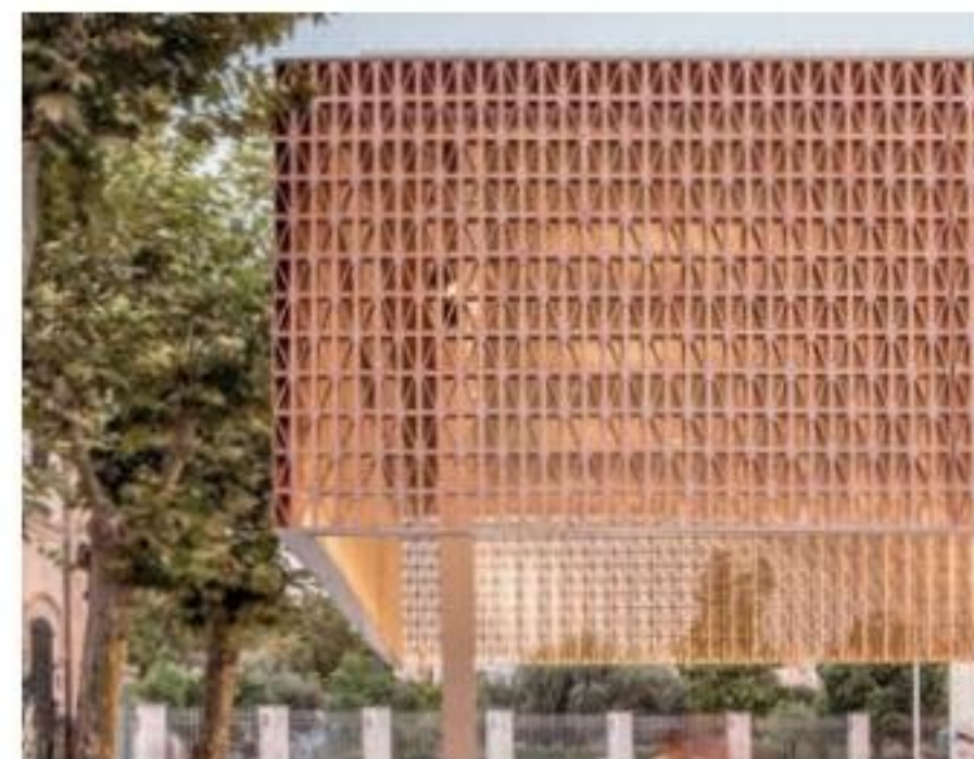
Nueva entrada a la estación intermodal de Palma. Foto: Adrià Goula.
