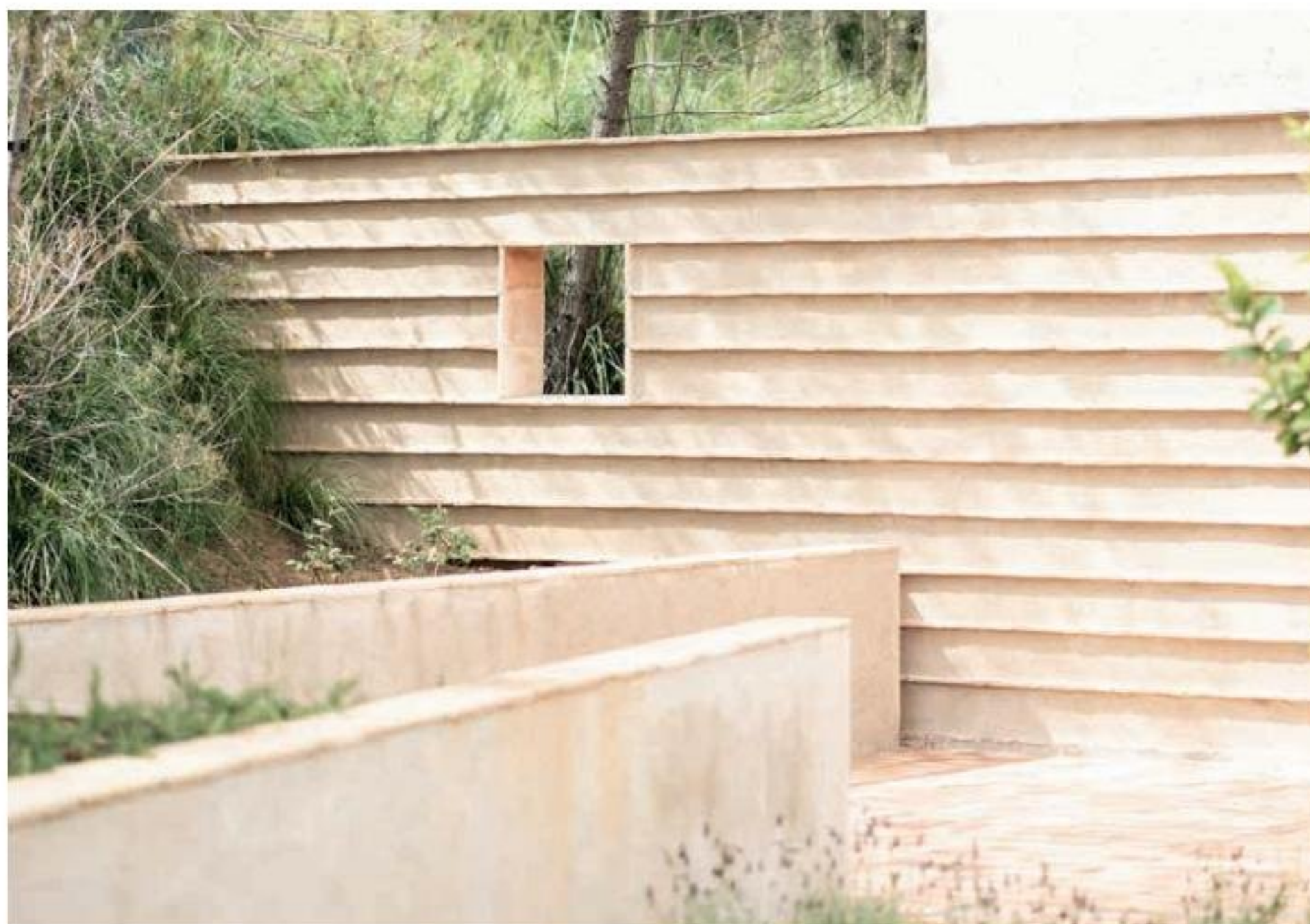
Exterior “Casa Ter” de Mesura. Fotografía: Salva López y Mesura.
