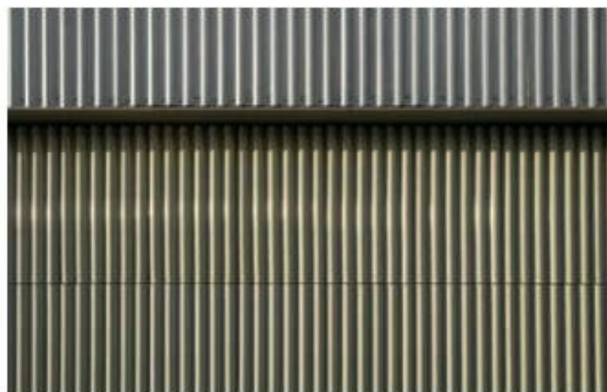
Campus de “Runnymede College” de los arquitectos Rojo / Fernández-Shaw. Mención de honor en la categoría de Arquitectura. Fotografía: Luis Asín.
