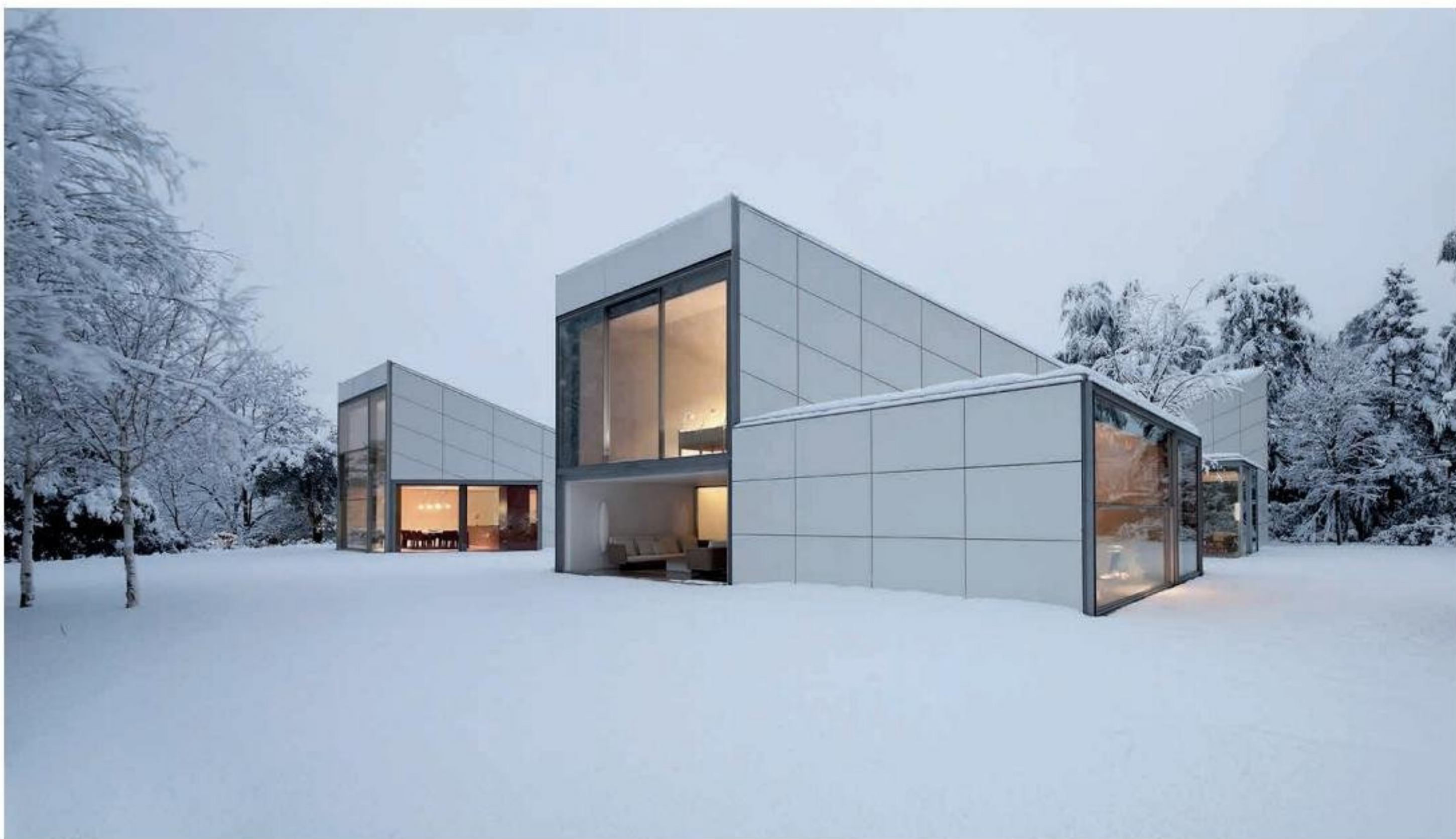
Casa AA de los arquitectos Carlos Ferrater y Xavier Martí, OAB (Barcelona). Obra construida en 2011. Piezas cerámicas de gran formato y mínimo espesor de Saloni.
