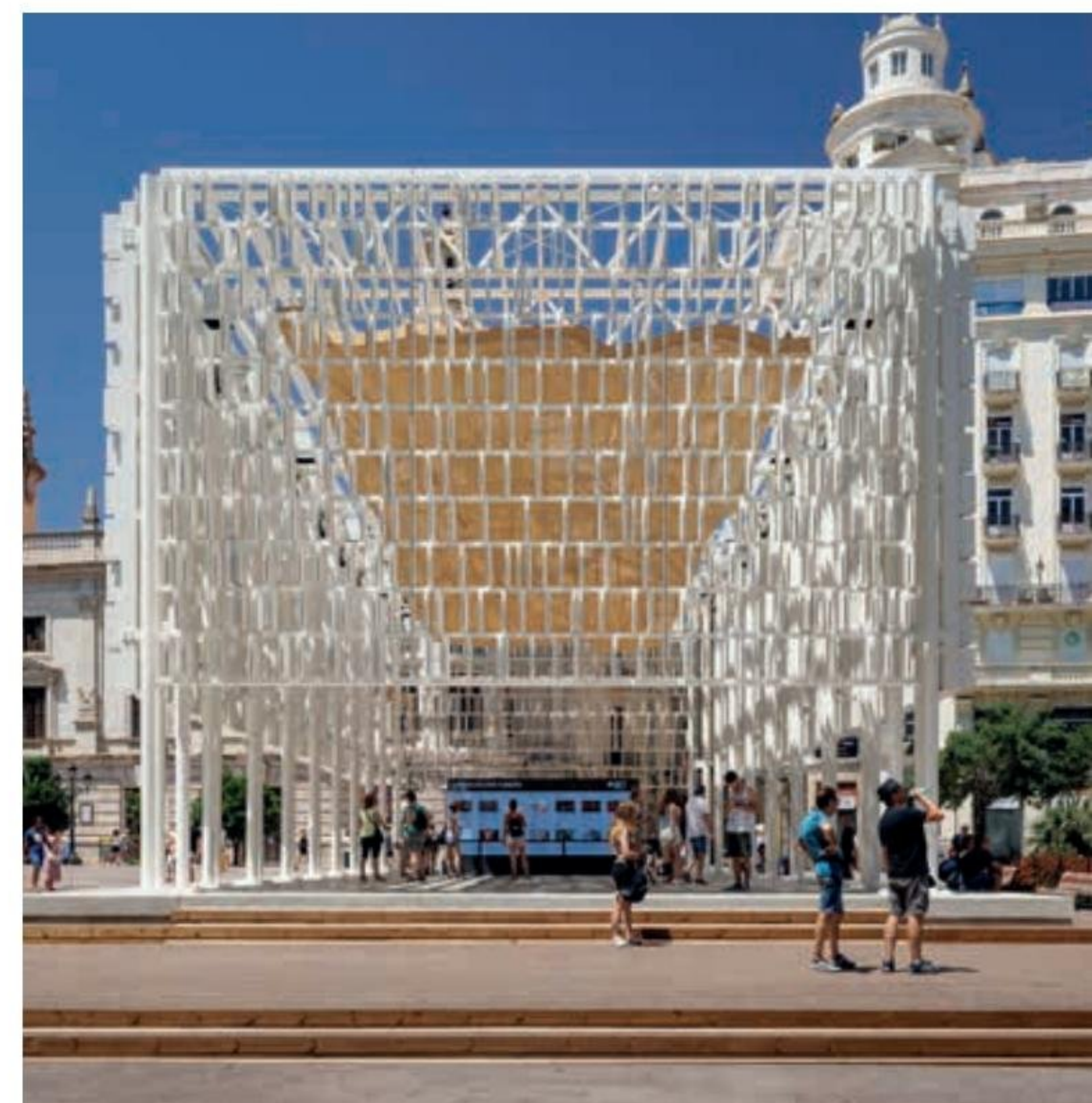
“Pabellón Ágora Valencia” de Archeha+Miguel Arraiz, mención arquitectura. Fotógrafo: Alejandro Gómez Vives.
