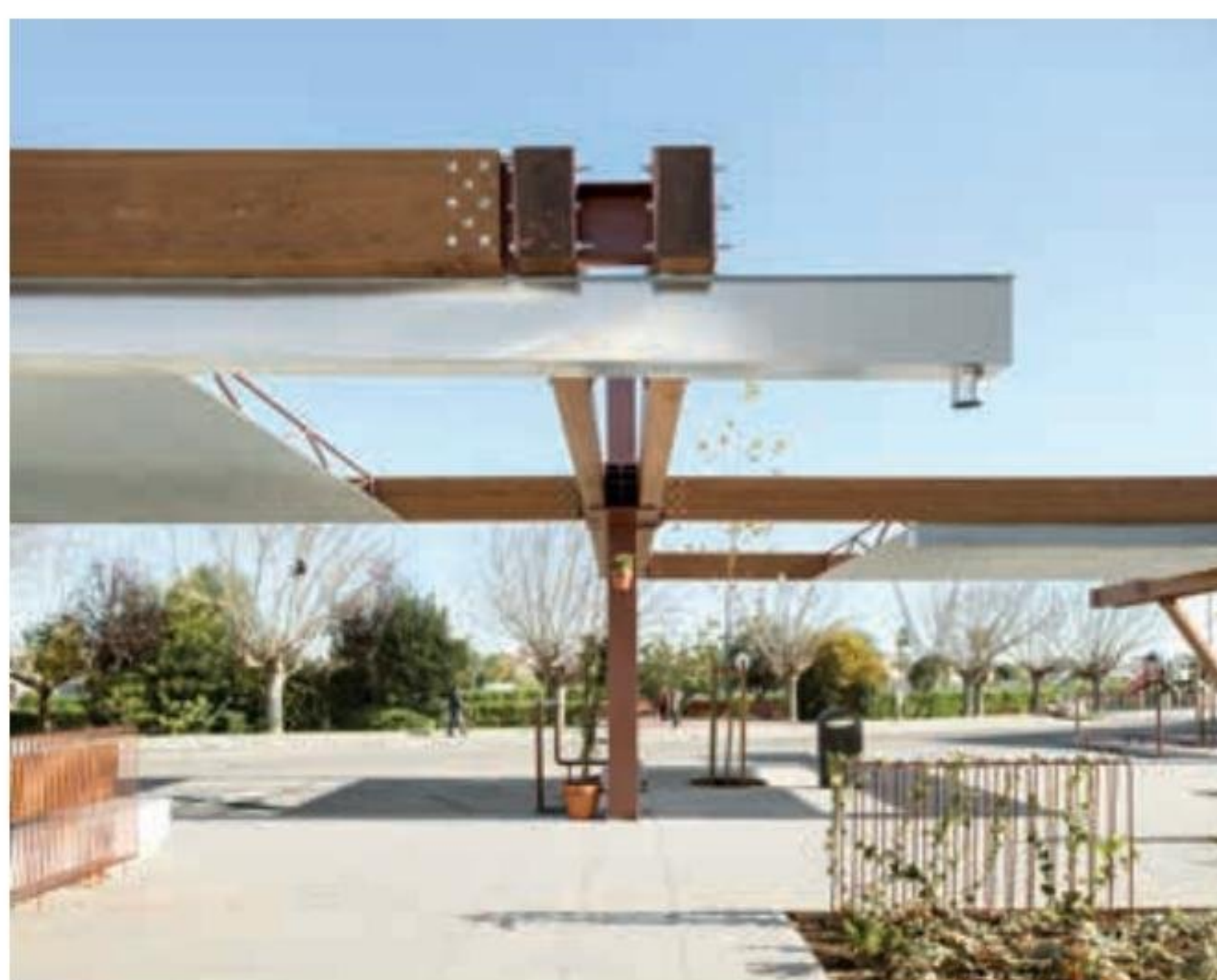
« Plaza + parada de autobuses en Vinarós » (Place + arrêt de bus à Vinarós) de La Errería * architecture office (Luis Navarro Jover + Carlos Sánchez García). Photographie : Milena Villalba.
