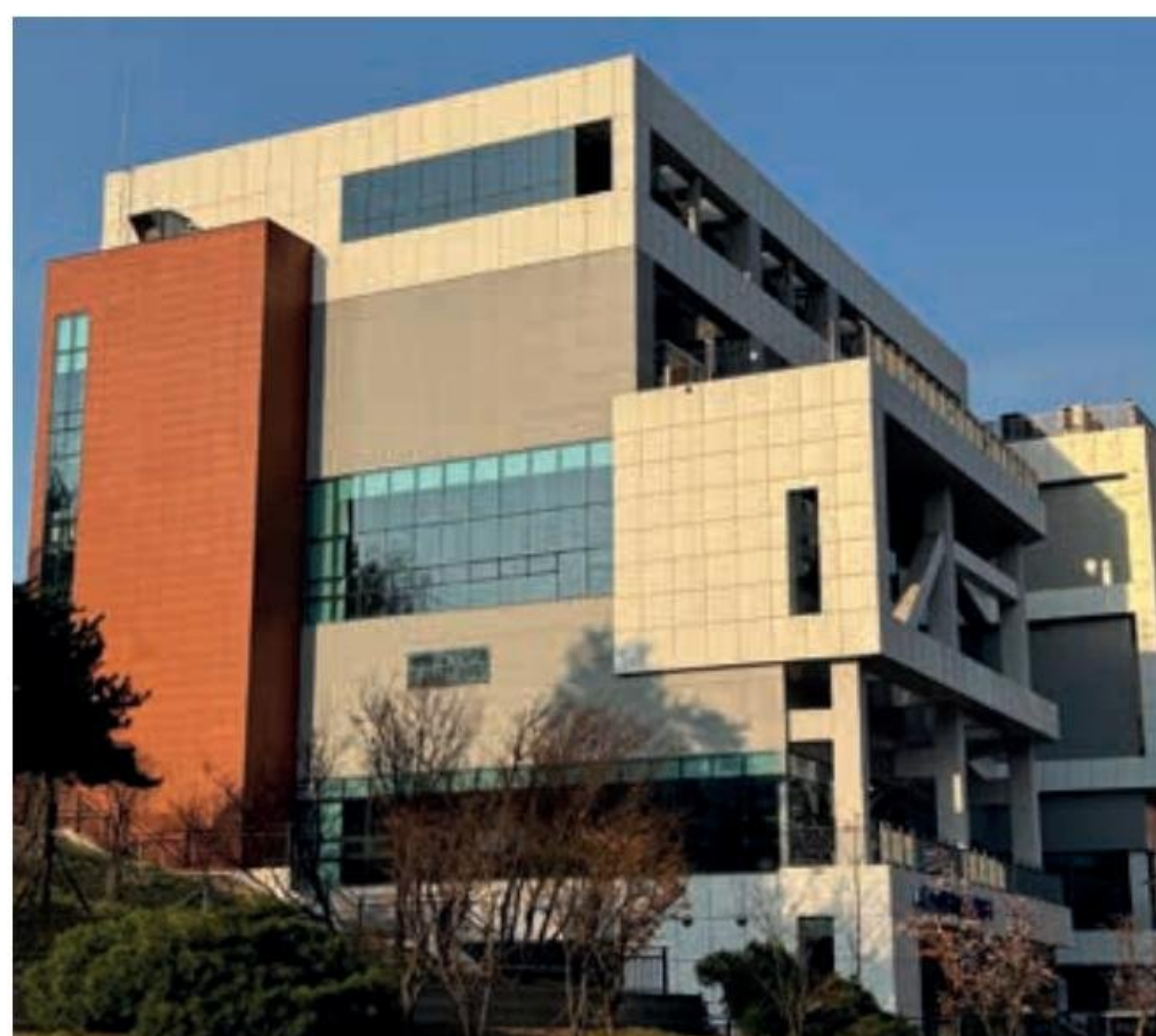
ALCALAGRES / Facciata ventilata realizzata con la serie Tecnika nei colori bianco (formato 60x60 cm), grigio (60x60 cm) e mango (30x60 cm). / Foto: Alcalagres.
