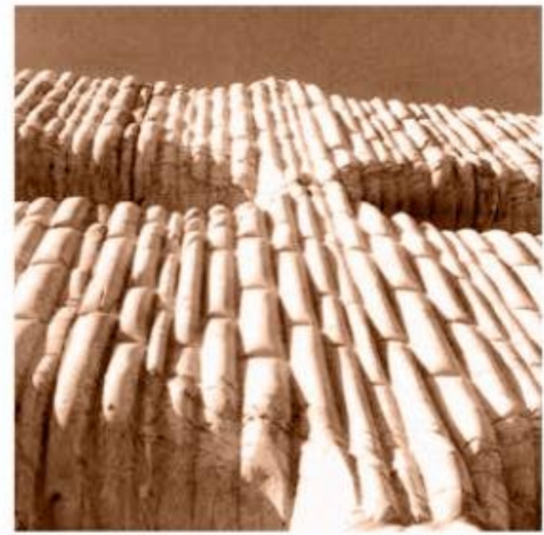
Fachada realizada con encofrados flexibles. Miguel Fisac, c. 1974
