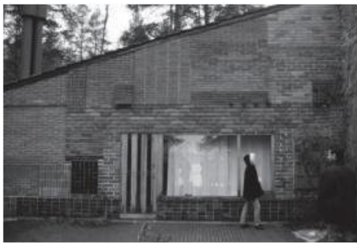
F13—Casa en Muuratsalo. Fragmento del muro “collage” del patio interior. Foto: A. M. Castillo
