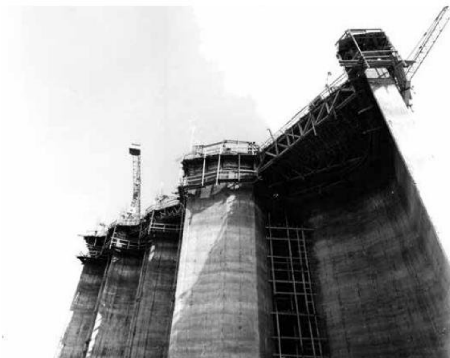
F3—Empleo de encofrados deslizantes. Archivo personal Raili Pietilä.
