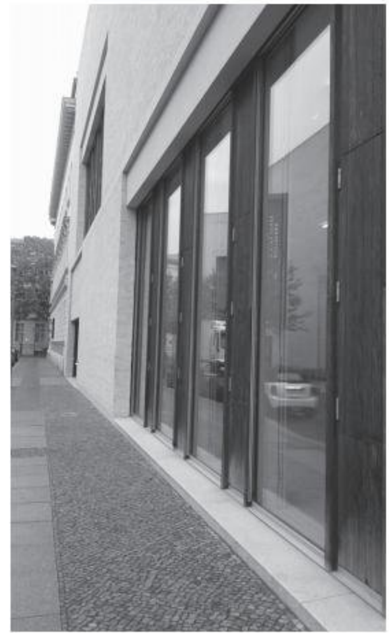
F20—Chipperfield, David. Gallery Building “Am Kupfergraben 10”, Berlín, 2003-2007. (Fotografía C. Labarta).
