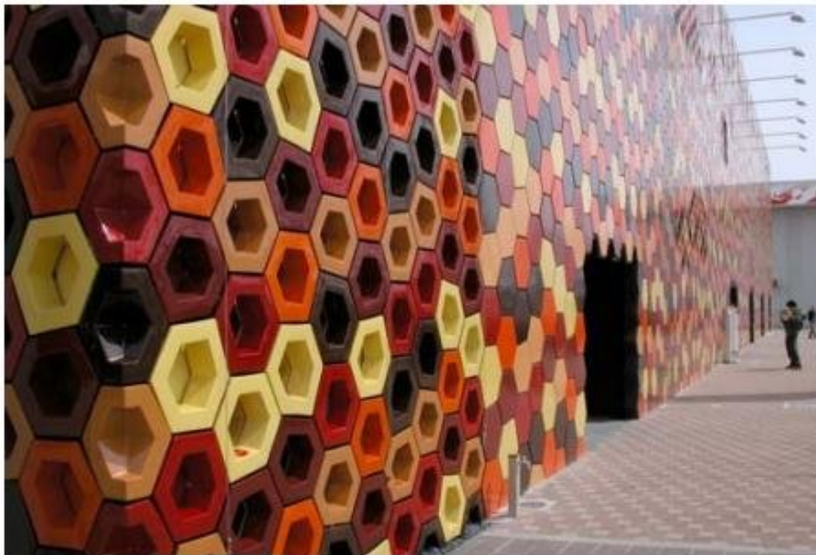
Piezas prensadas en estado plástico. Pabellón España en la exposición universal de Aichi
